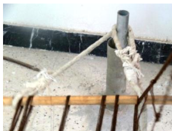
شکل ۹۶ - بستن طناب به دو سر چوب سرکار
