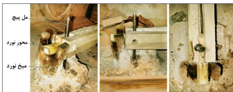
شکل ۳۷- نماهای روبه‌رو، جانبی و بالا از میخ نورد
