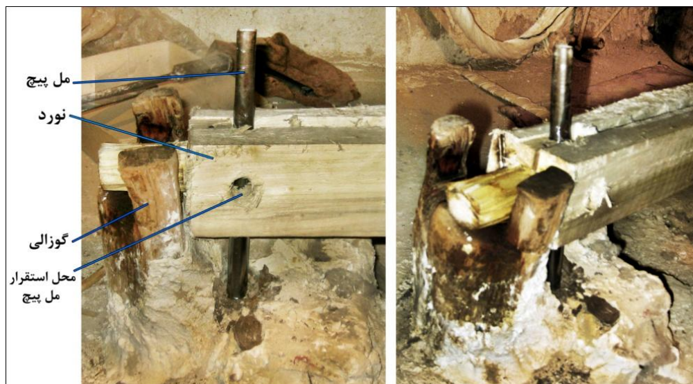
شکل ۲۷- نمای روبه‌رو و نمای جانبی از مل پیچ
