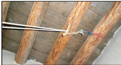
شکل ۲۶ - ریسمان و کِلاک که به تیرک‌های سقف متصل شده‌اند.
