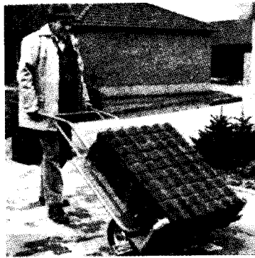
شکل ۹. حمل بلوک با فرغون مخصوص
