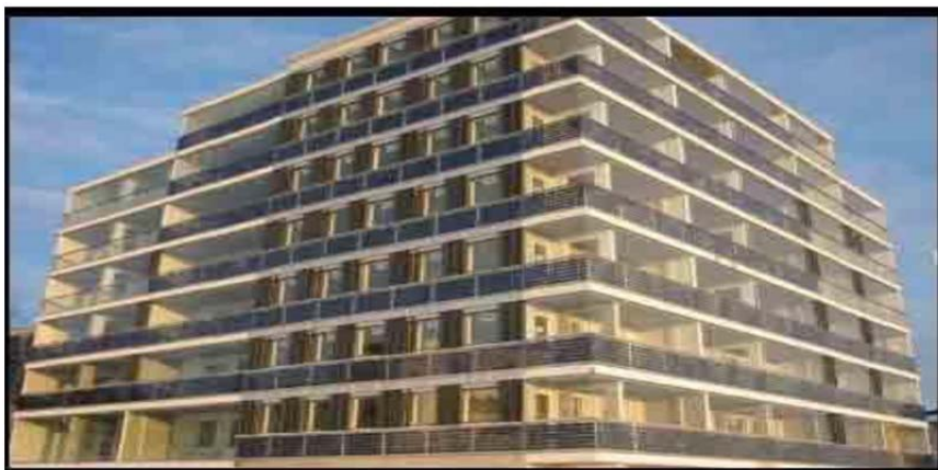
شکل (۳-۶): نصب آرایه‌های فتوولتائیک به عنوان نرده بالکن
