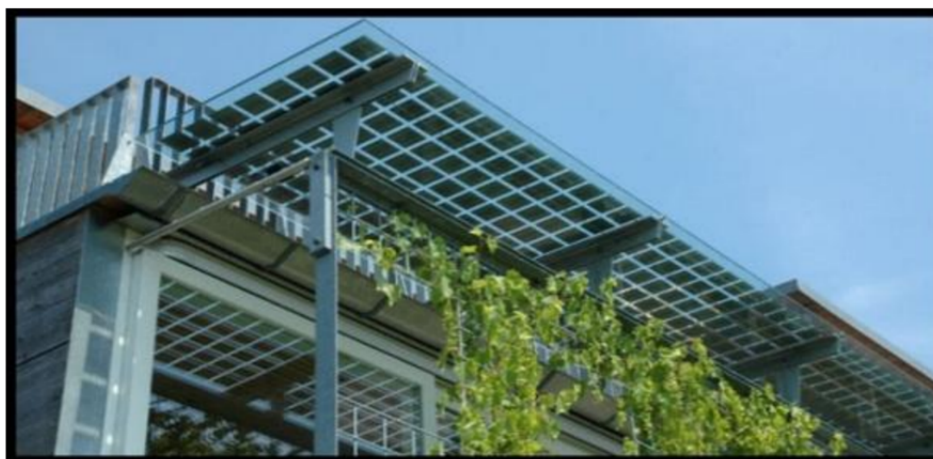
شکل (۳-۷): نصب آرایه‌های فتوولتائیک به عنوان سایه بان
