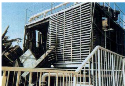
شکل ۹-۲ آسیب دیدگی برج خنک کننده. به علت وجود پرکننده‌ها (سازه‌ها) هیچ لغزشی مشاهده نشده است.
