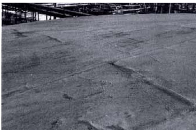
شکل ۶-۲۸ پوشش سقف بطانه‌ای
