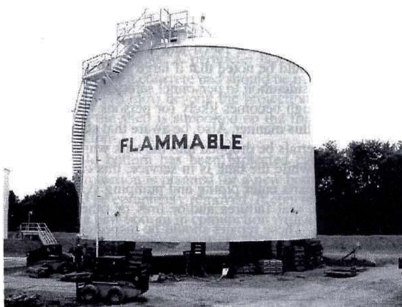
شکل ۶-۱۹ مخزن بلند شده برای تعمیر لایه زیری
