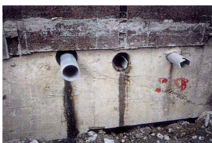
شکل ۹-۴ لوله کشی در محل اتصال با ساختمان
