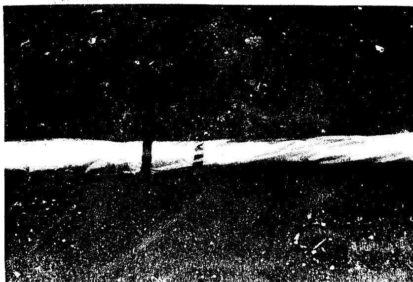
در صورت ایجاد شکست و یا نقصی در لوله  $D_1$  قسمت معیوب را با بکار بردن اتصالهای الاستیک تعمیر کنید همان‌طوری‌که در تصویر ۱۰۱ نشان داده شده است قسمت معیوب را ببرید و لوله جدیدی بجای آن قرار دهید و سپس آنرا باز و عدد اتصال الاستیکی بدو لوله قبلی وصل کنید.
