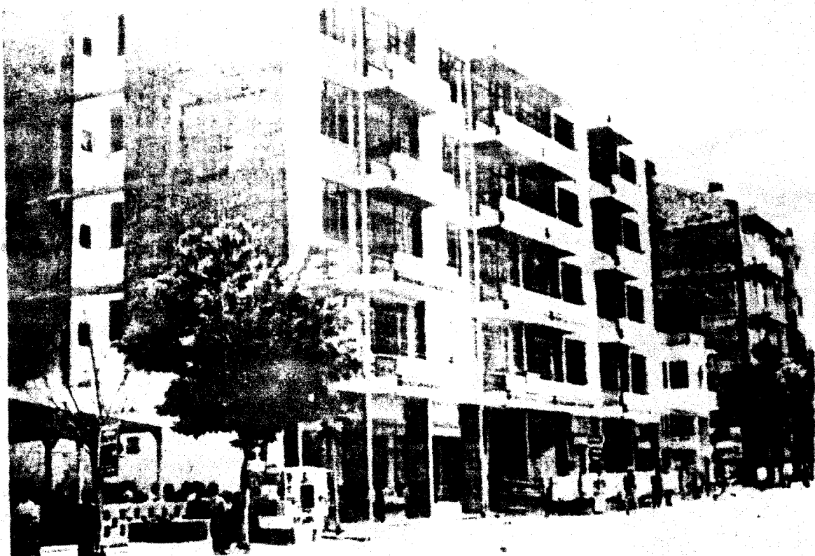
ساختمان آپارتمان ۵ طبقه بربراولو واقع در شهربردور (باسکلت ساختمان صدمه وارد نشده ولی دیوارهای داخلی که از بلوک بتنی است صدمه فراوان دیده است)
