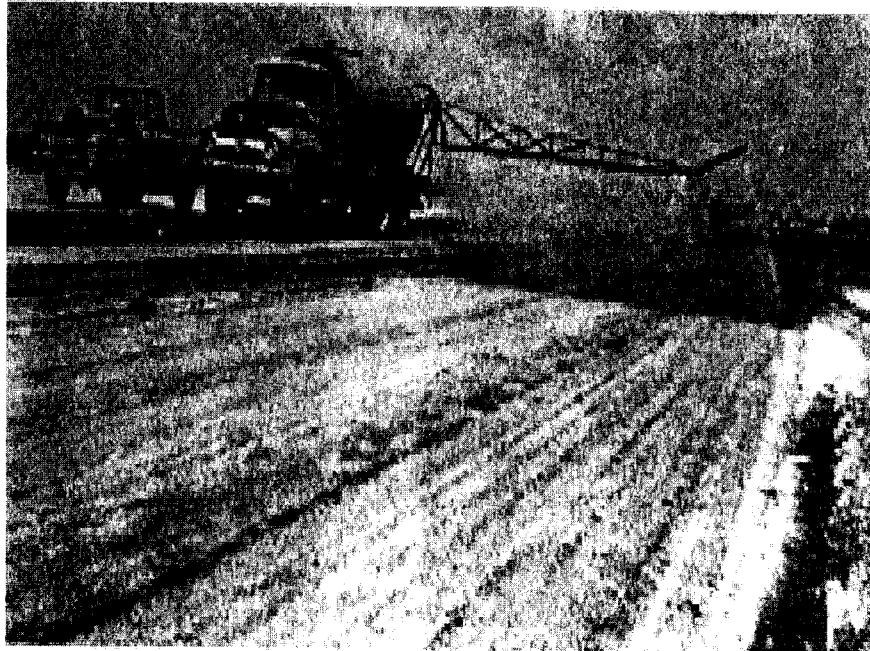
شکل (پ - ۹): آپاشی برای عمل آوردن خاک بستر ثبیت شده با آهک
