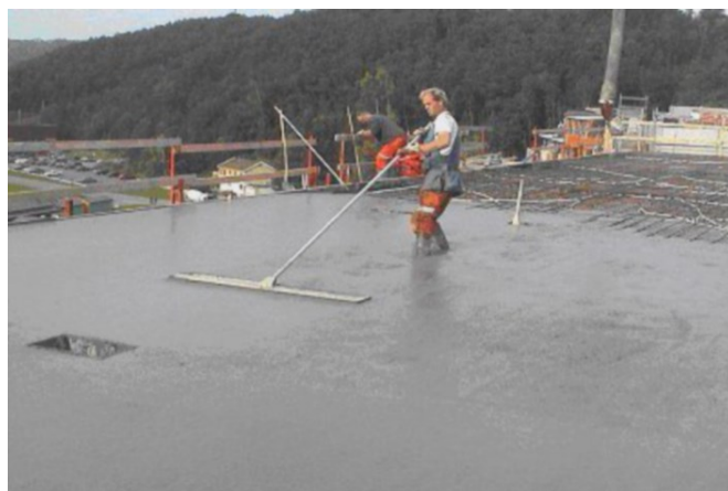
شکل ۷-۴ پرداخت سطح دال با استفاده از ماله دسته بلند
