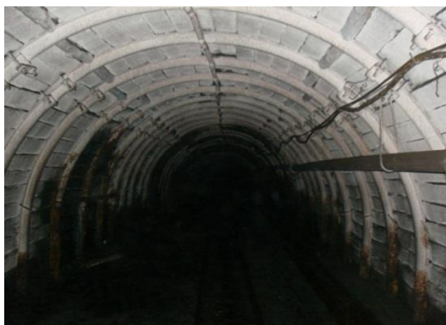
شکل ۵-۱- تونل اصلی اندود شده با آب آهک
