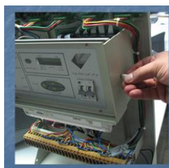
پیچ‌های استحکام پنل به بدنه کنترلر
