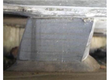
غیر اضطراری: تغییر شکل کمتر از نصف ارتفاع است
