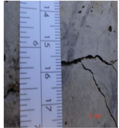
اضطرابی: ترک پیشرفته سازه‌ای
