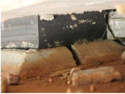
اضطراری: ترک خوردگی شدید و شکست گروت نشیمن تکیه‌گاه
