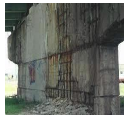
اضطراری: آسیب گسترده در پایه دیواری. آرماتورها کاملاً نمایان شده و دچار خوردگی شده‌اند.
