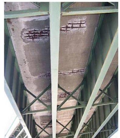
اضطرابی: از بین رفتن ایزولاسیون عرشه اضمحلال بتن زیر عرشه و نمایان شدن آرماتورها
