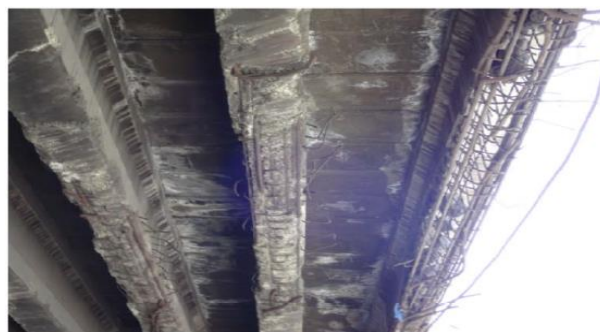
اضطراری: برخورد وسیله نقلیه با زیر تیر، اضمحلال بتن و از بین رفتن ایزولاسیون عرشه
