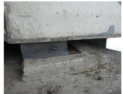
اضطراری: جابجایی تکیه‌گاه الاستومریک از محل خود
