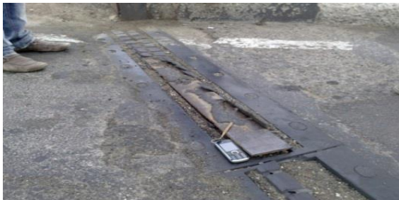
اضطراب: حرکات مشهود و سرو صدا در درز هنگام عبور ترافیک در تمام خطوط عبوری. فقدان تعدادی از پیچ‌های درز انبساط. از بین رفتن رویه لاستیکی صفحه و از جا بلند شدن صفحه رویه درز
