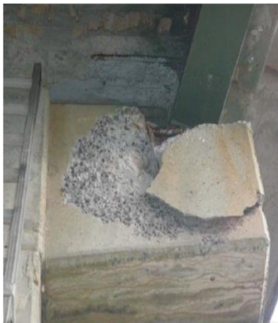
آنی: قلوه‌کن شدگی شدید سر ستون فروریختن بخشی از آن
