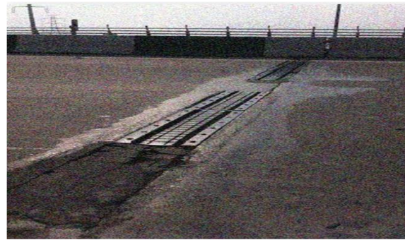
اضطراب: حرکات مشهود درز و ایجاد سر و صدا هنگام عبور ترافیک در تمام خطوط عبوری. مفقود شدن تعدادی از پیچ‌های درز لاستیک قسمتی از درز کاملاً از جا در آمده و با آسفالت پر شده است.
