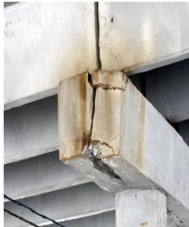
آنی: پکیدگی سر ستون بتنی وجود امکان فرو ریزش
