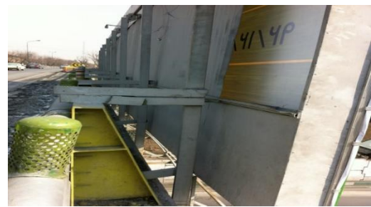
نصب تابلو تبلیغاتی (قطعات الحاقی غیر استاندارد) به پل
