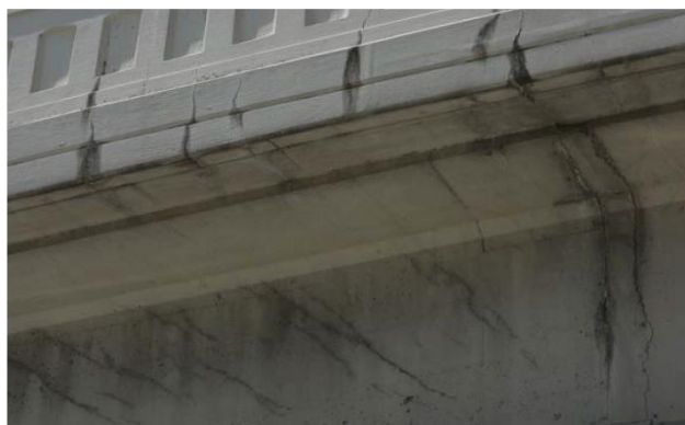
اضطراری: ایجاد ترک‌های مشهود و گسترده در تیر و قرنیز عرشه
