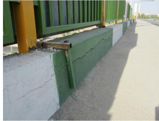
اضطراری: نحوه اتصال نامناسب قطعات الحاقی (تابلوهای تبلیغاتی، گلدان و...) به جدول که منجر به ایجاد ترک طولی و آسیب‌دیدگی شده است.
