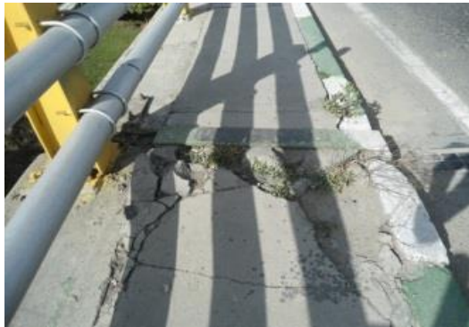
آنی: ترک‌های عمیق در بتن قابل رویت است بتن نشست کرده است. جدول آسیب دیده‌اند. رنگ‌آمیزی از بین رفته و نیاز به رنگ مجدد دارد.
