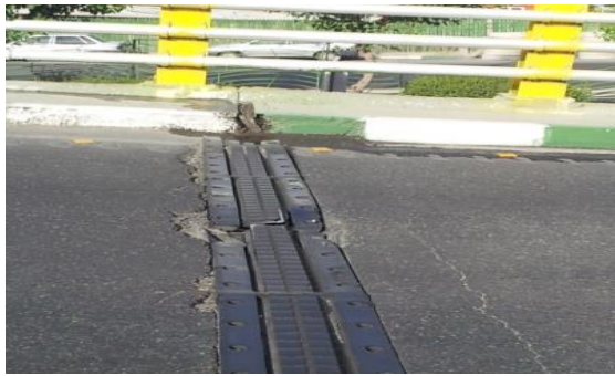
اضطراب: ایجاد سر و صدای زیاد هنگام عبور ترافیک. قلوه کن شدگی و آسیب بتن درز و وجود ترک مشهود در مجاور درز
