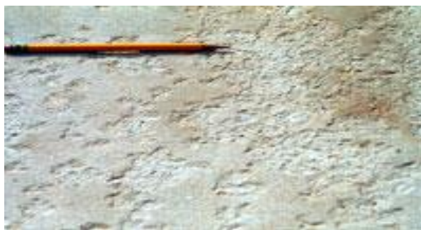
شکل ۱: پوسته شدن بتن
