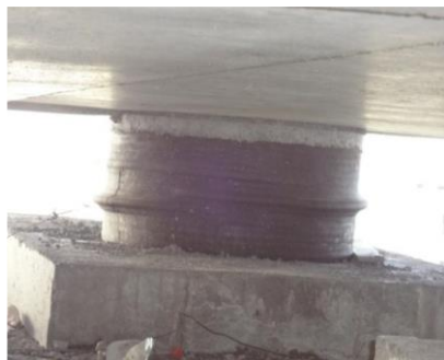
آنی: بیرون زدگی و تورم لاستیک تکیه‌گاه الاستومریک به طور کامل
