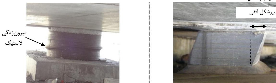
شکل ۱۷: تغییر شکل افقی و تورم در تکیه‌گاه
