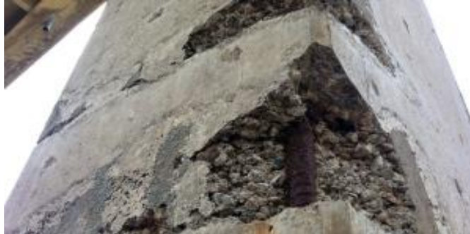
شکل ۳: قلوه کن شدن بتن
