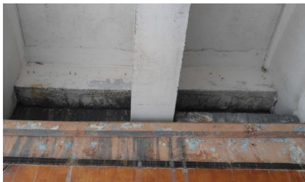
اضطراری: نش آب، خوردگی بتن، نمایان شدن آرماتورهای تیر و ترک خوردن انتهای دال
