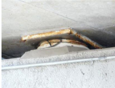
غیر اضطراری: از بین رفتن درزگیر لاستیکی
