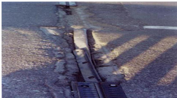
آنی: بخش اعظم درز بطور کامل (ورق رویه، لاستیک درز و بتن اطراف درز) کنده شده و از بین رفته است و ایجاد چاله و اختلال در ترافیک نموده است.
