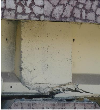
اضطرابی: ترک پیشرفته سازه‌ای
