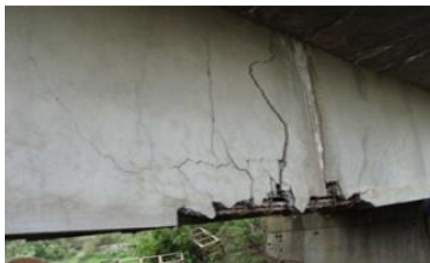
اضطراری: قلوه‌کن شدن شدید و نمایان شدن تسلیحات بتن و ایجاد ترک در تیر بتنی
