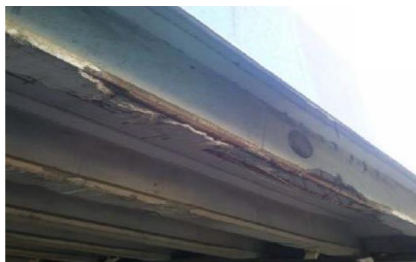
اضطراری: قلوه‌کن شدن شدید و نمایان شدن تسلیحات بتن
