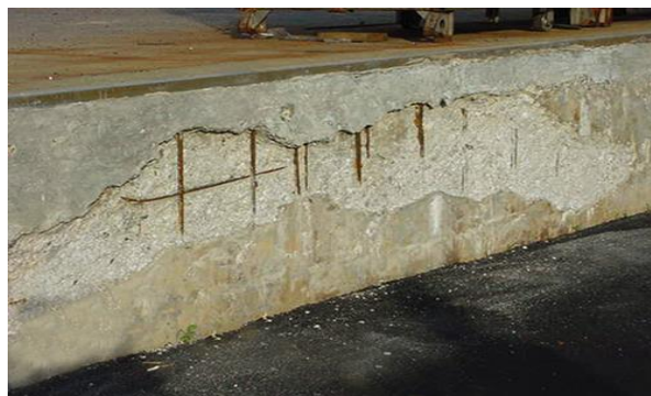
شکل ۲: ورقه‌ورقه شدن سطح بتن
