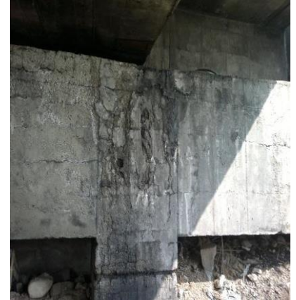
غیر اضطرابی: ترک‌های پیشرفته با رطوبت و شوره‌زدگی و آثار زنگار
