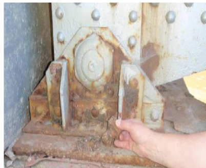
اضطراری: خوردگی شدید تکیه‌گاه و شکستن یکی از بولت‌ها
