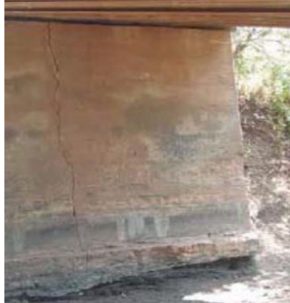
اضطرابی: ترک قائم با عرض زیاد اضمحلال بتن و از بین رفتن بتن فونداسیون کوله
