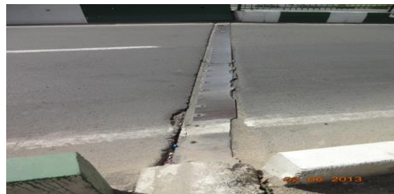
اضطراب: ایجاد سر و صدا هنگام عبور ترافیک و قلوه کن شدن و آسیب بتن درز
