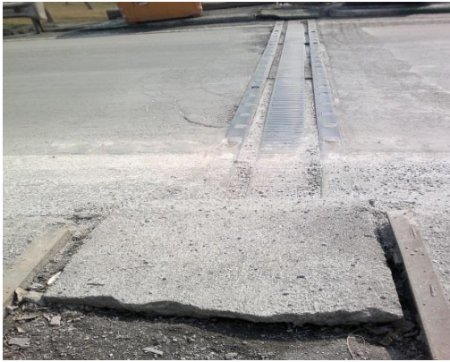
اضطراری: انسداد و عدم ادامه‌داری درز انبساط در پیاده‌رو و خرابی روکش پیاده‌رو در محل درز
