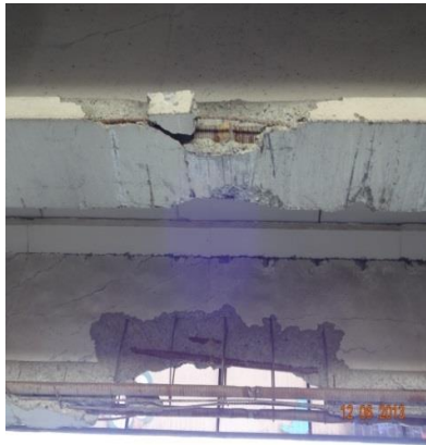
اضطرابی: - آثار برخورد شدید - قلوه‌کن شدگی و نمایان شدگی آرماتورها و کابل‌ها در تیر
