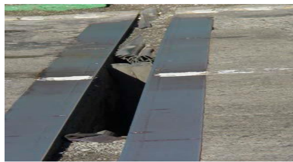
آنی: لاستیک درز کنده شده است و باعث اختلال در ترافیک عبوری شده است.
