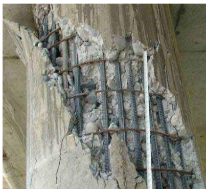
آنی: قسمت فوقانی ستون، ترک برشی خورده است.
