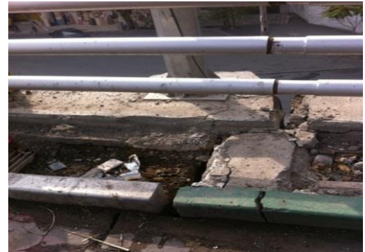
آنی: از بین رفتن پوشش سطح پیاده‌رو و ترک خوردگی عرضی در امتداد درز انبساط وجود چاله در سطح پیاده‌رو
