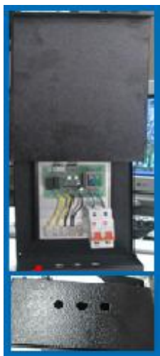
شکل (۱۳): کابینت کنترلر چشمک‌زن برقی
