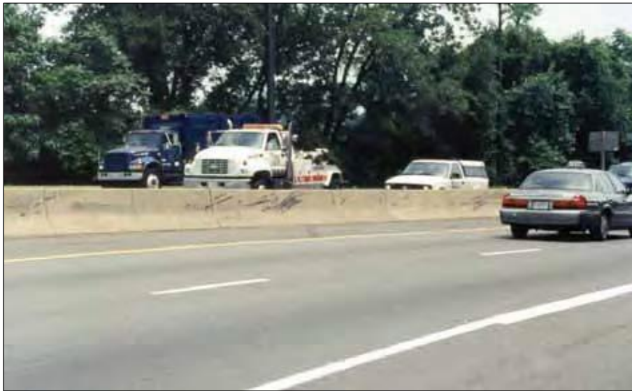
شکل ۴-۷- نمونه‌ای از حفاظ میانی بتنی
