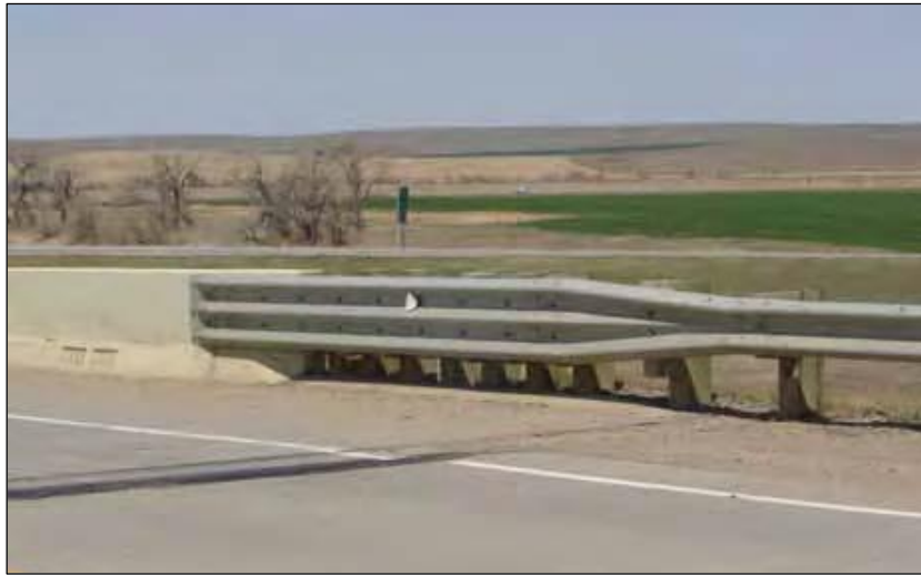
شکل ۵-۱۵- نمونه‌ای از ناحیه انتقالی بین حفاظ‌های فلزی و بتنی
