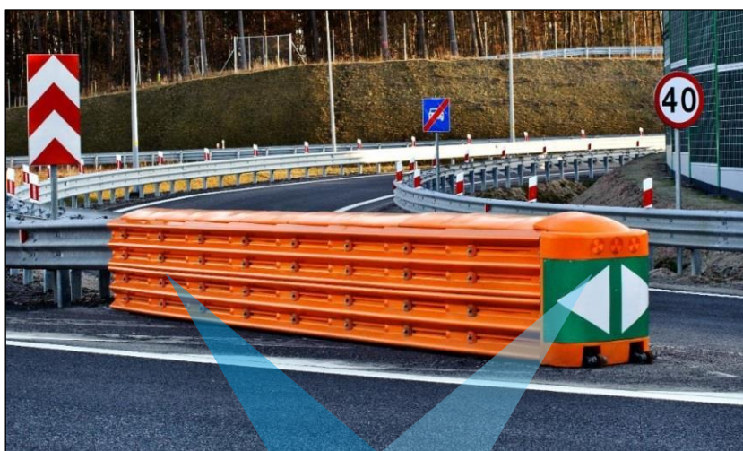
شکل ۶-۶- استفاده از کاشن تانک در محل رابط خروجی
