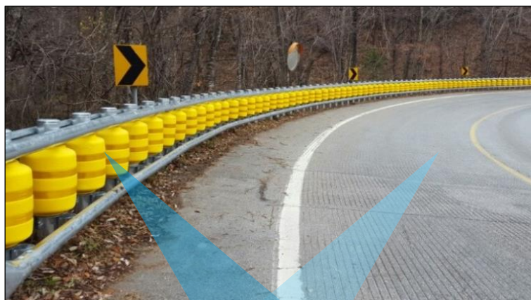
شکل ۳-۱- استفاده از حفاظ غلتکی به عنوان حفاظ طولی کناری
