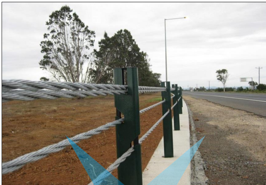
شکل ۲-۳- نمونه‌ای از حفاظ‌های فلزی کابلی
