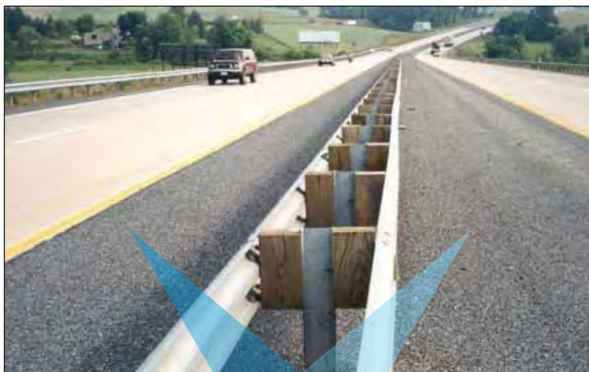
شکل ۳-۴- نمونه‌ای از حفاظ میانی دو موجی با پایه‌های قوی
