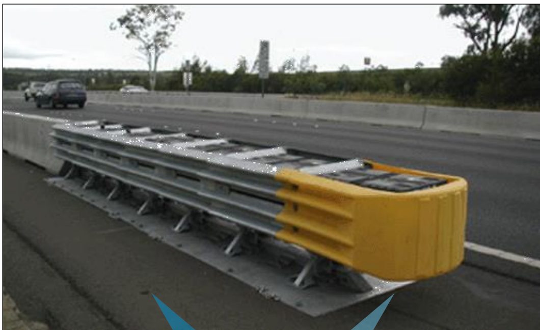
شکل ۴-۶- ضربه‌گیر کواد گارد
