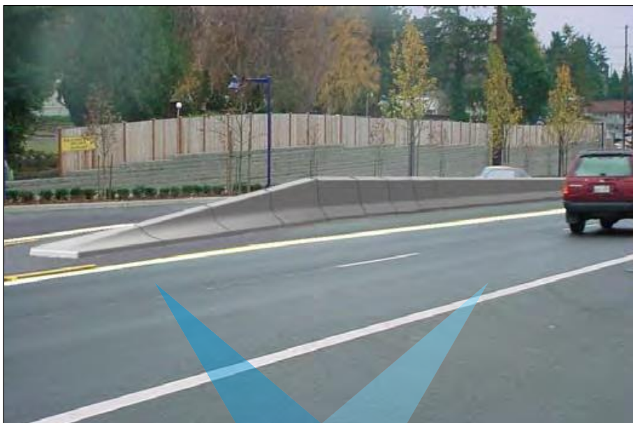
شکل ۵-۲۰- نمونه‌ای از شیب‌دار کردن ابتدای حفاظ بتنی
