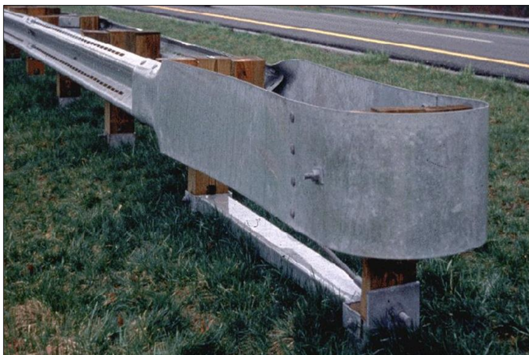
شکل ۶-۲- ضربه‌گیر ابتدایی مستهلک کننده
