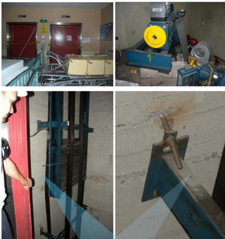
شکل پ ۲۴-۲- آسیب واردہ به آسانسور در زلزله ۲۰۱۰ شیلی، موتور مهارنشده آسانسور از تکیه گاه خود خارج شده ریل های جابجایی آسانسور تحت اثر بار قائم واردہ خم شده اند و بولت های اتصال ریل از بتن خارج شده اند.
