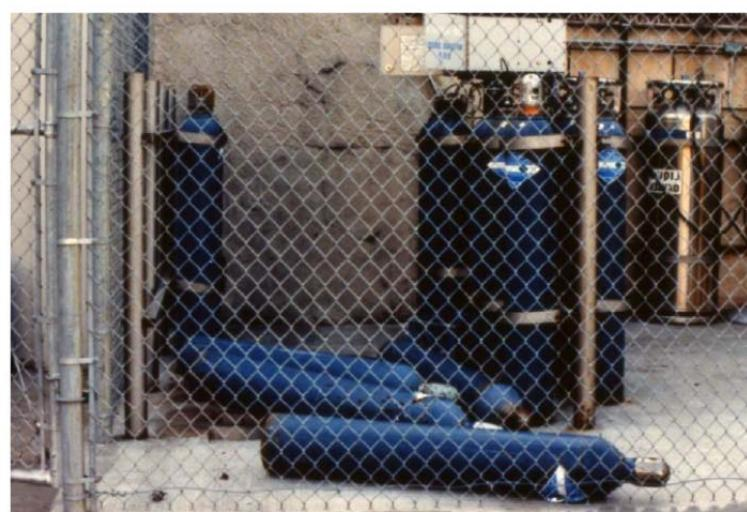
شکل پ ۲-۱۷- افتادن و خطر انفجار سیلندرهای اکسیژن مهار نشده در زلزله نورث ریچ ۱۹۹۴
