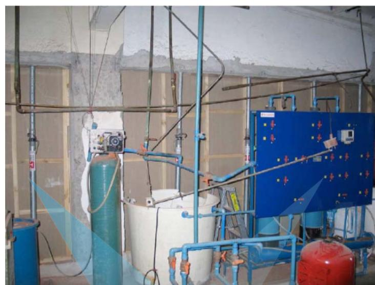
شکل پ ۷-۲- خرابی دیوار میان قابی آجری و افتادن آن بر روی دو مخزن آب ۶۰۰ لیتری آب شد که باعث ورود آب به ۳ تا از ۶ اطاق عمل بیمارستان واقع در شیلی شد و از مدار خارج شدن آنها گردید (زلزله ۲۰۱۰ شیلی)
