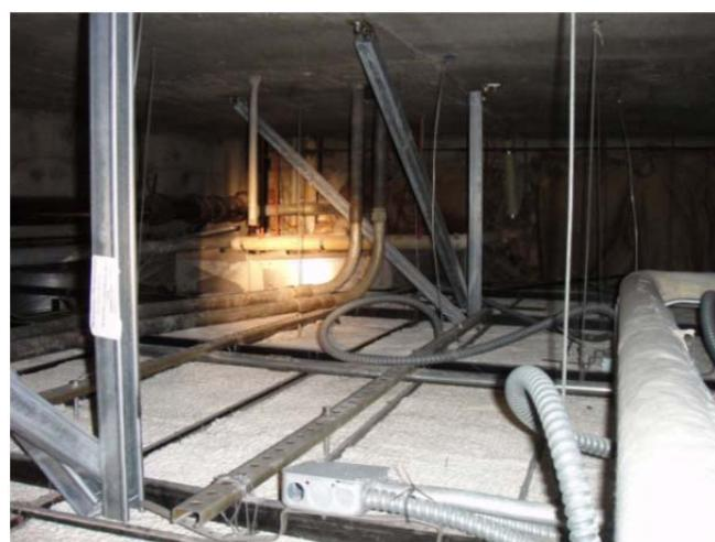
شکل ۱۳-۵- جزئیات سقف لایه گچی مهاربندی شده معلق با اعضای خمشی در فواصل ۱/۸ تا ۲/۴ متری تأمین شده است .
