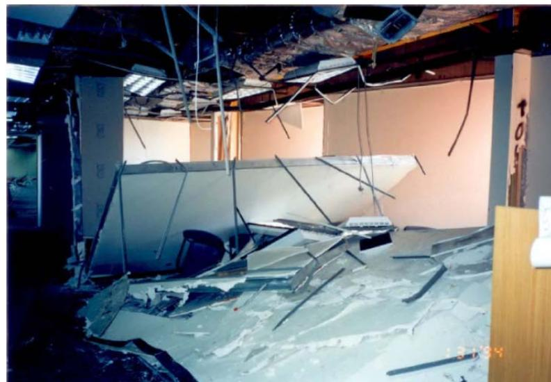
شکل پ-۲-۸- خرابی مهارهای نامناسب پارتیشن نیمه ارتفاع فلزی در زلزله ۱۹۹۴ نورث ریج
