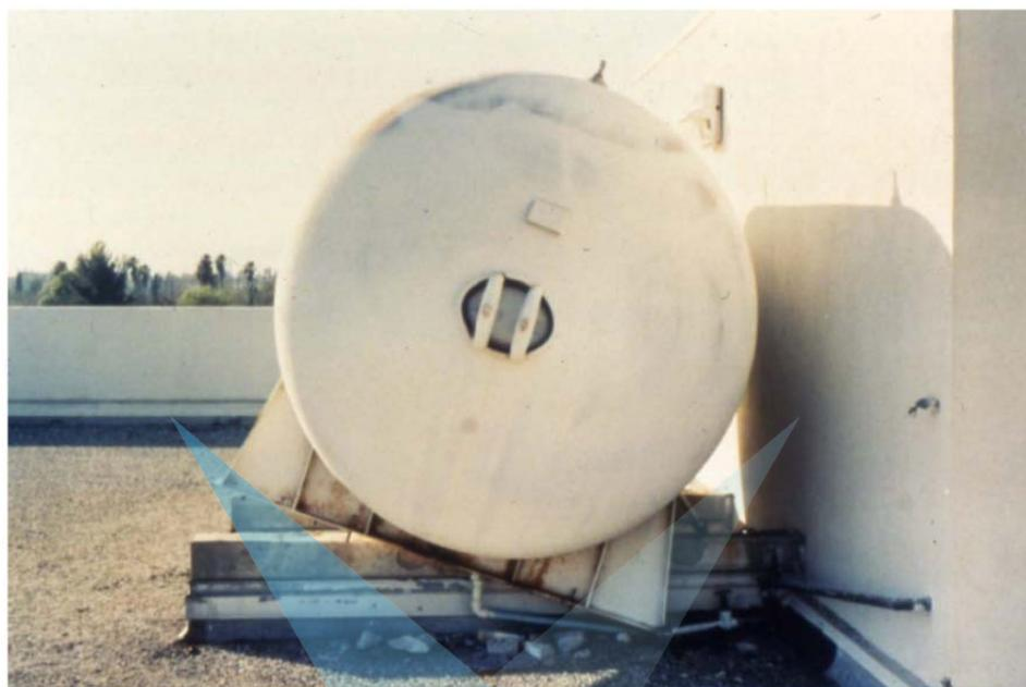
شکل پ ۱۵- ۱- جابجایی و خارج شدن مخزن واقع بر روی بام بیمارستان گرانادا هیل در زلزله نورث ریچ که باعث از مدار خارج شدن مخزن و خرابی لوله‌های منتهی به آن شده است.
