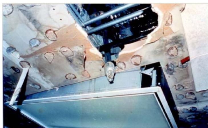
شکل پ-۵- خرابی لوله آپیاش اطفای حریق سقف در بیمارستان Olive View در سیلما، کالیفرنیا در نتیجه زلزله نورث ریج ۱۹۹۴ پارگی لوله در محل خم بر اثر جابجایی متفاوت سقف و لوله اتفاق افتاده
