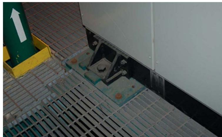
شکل ۵-۳۷-۵- نمونه اجرا شده اتصال جزء غیر سازه‌ای به وسیله نبشی
