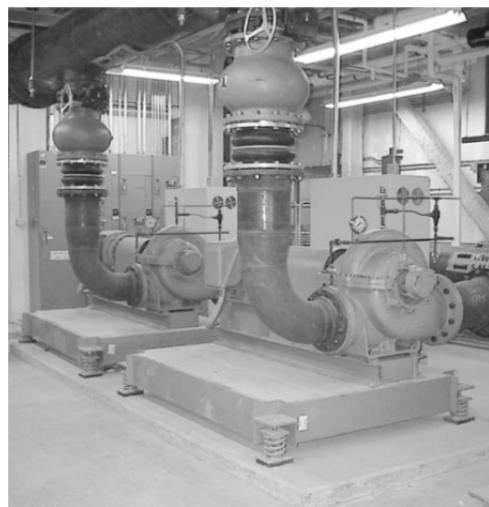
شکل ۵-۱۵۸- نمونه استفاده از اتصال شکل پذیر در محل اتصال لوله به پمپ
