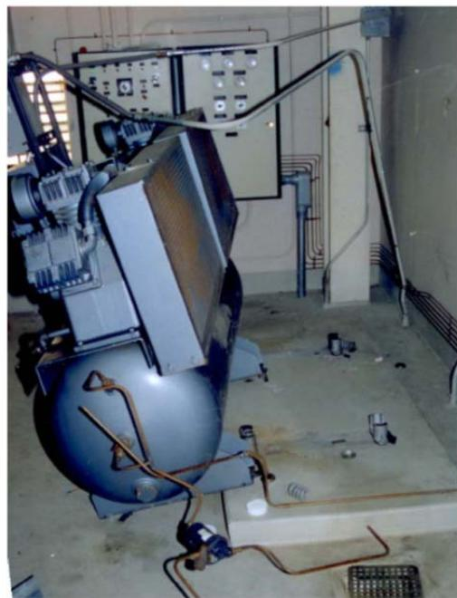
شکل پ ۱۲-۲- خرابی کمپرسور متصل به کف به وسیله جداساز ارتعاش کف نامناسب در زلزله ۱۹۹۴ نورث ریچ
