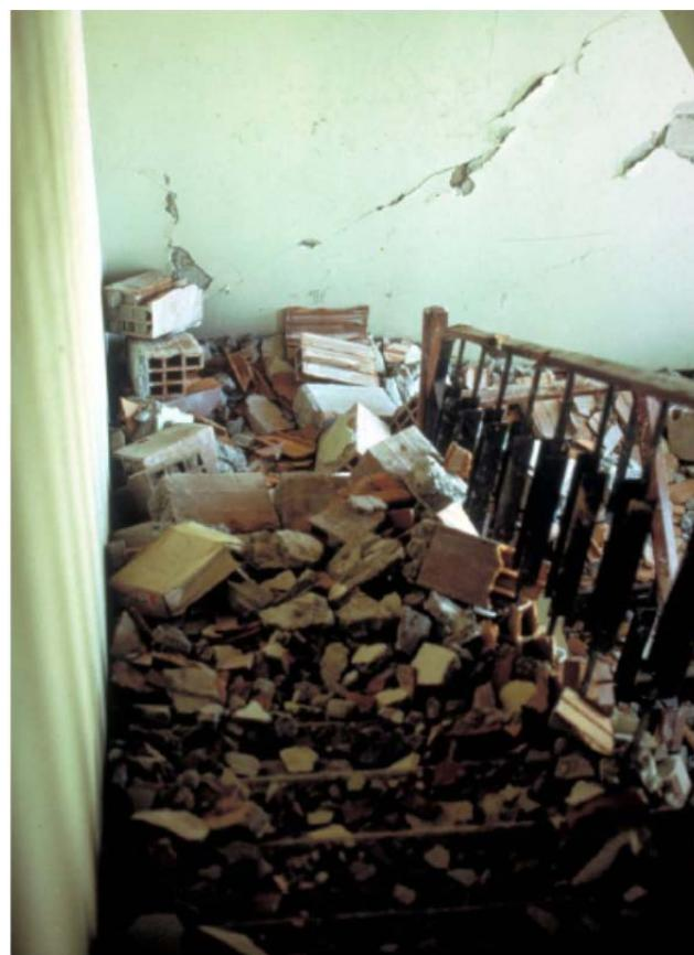
شکل پ ۲-۶- نمونه‌ای از پوشیده شدن راه پله‌ها از تکه‌ها و قطعات ناشی از خرابی پارکیشن‌های اطراف راه پله که باعث غیرقابل استفاده شدن راه پله پس از زلزله گردید (زلزله ۱۹۷۲ نیکاراگوا- بزرگ ۶/۲)
