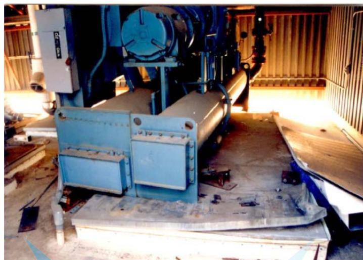
شکل پ ۱۱-۲ - خرابی چیلر متصل به کف به علت مقاومت ناکافی اتصال در برابر بلندشدنی در زلزله ۱۹۹۴ نورث ریچ
