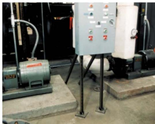
شکل ۱۵۰-۵- اتصال کنترل پنل با مهار(مهار به این شکل کافی نیست)
