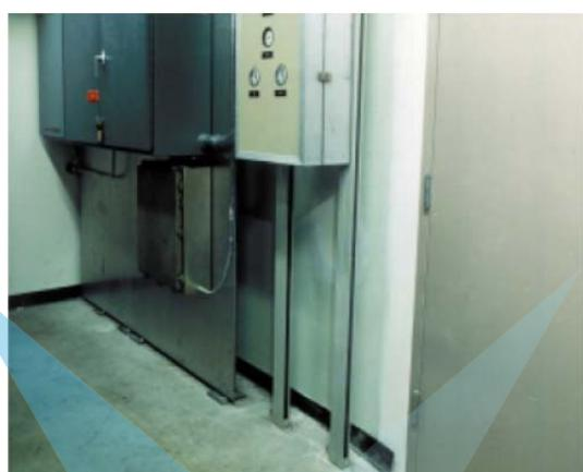
شکل ۱۵۱-۵- دو روش مختلف برای نگهداری کنترل پنل: با استفاده از یک صفحه فولادی متصل به کف و سقف با استفاده از قلاب‌های فولادی(چپ): با استفاده از پایه‌های امتداد یافته تا کف و سقف (راست)
