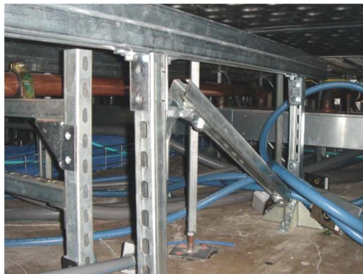
شکل ۵-۲۶- قاب بندی فولادی برای مهار کف کاذب
