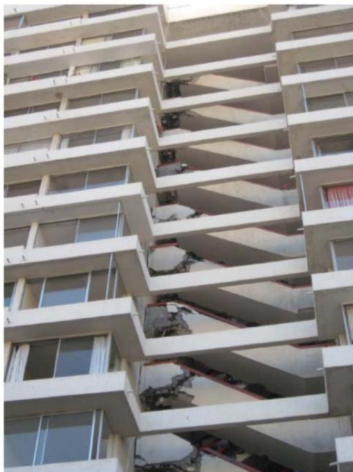
شکل پ ۱۰-۲ - خرابی راهپله تمام طبقات ساختمان در Vina del mar در زلزله ۲۰۱۰ شیلی به بزرگا ۸.۸ راهپله‌ها به صورت صلب به طبقات متصل شده بودند و به صورت بادبند قطری عمل کرده‌اند در حالی که برای این طراحی نشده‌اند.
