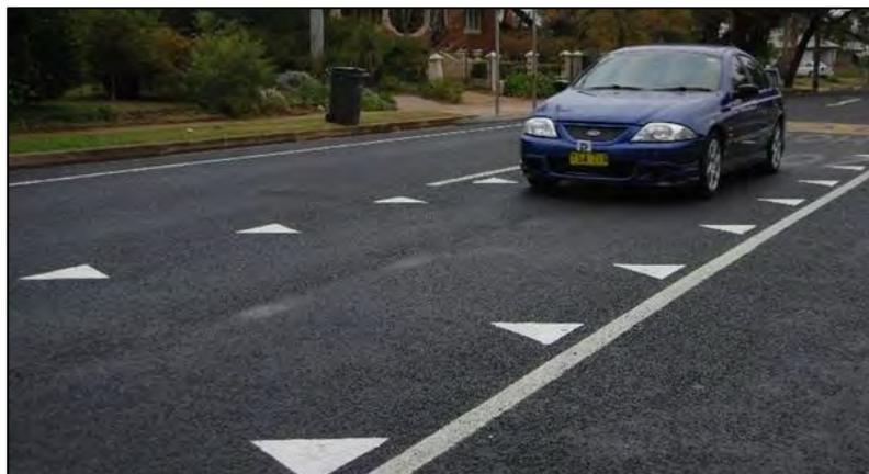
شکل ۲-۲۴: خط‌کشی دندانه‌های حاشیه‌ای
