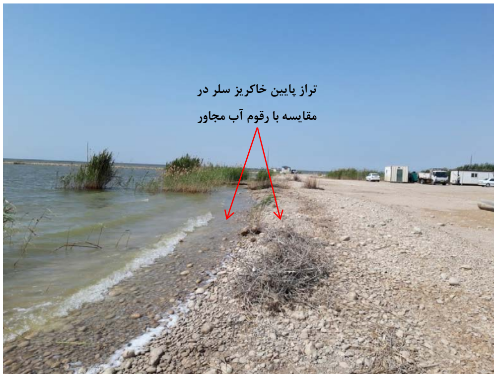
شکل ۲-۵ تراز پایین خاکریز سله در مقایسه با رقوم آب مجاور در میدان نفتی آزادگان جنوبی
