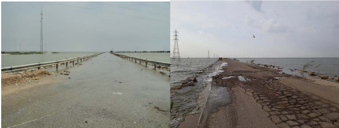
شکل ۴-۵ نشست‌های انتقال یافته به روسازی جاده و تخریب آن در جاده یاران شمالی و روگذری آب
