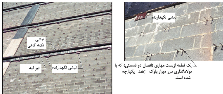
شکل ۵-۱۷- جزئیات اجرایی اتصال نبشی تکیه‌گاهی به دیوار پشتیبان
