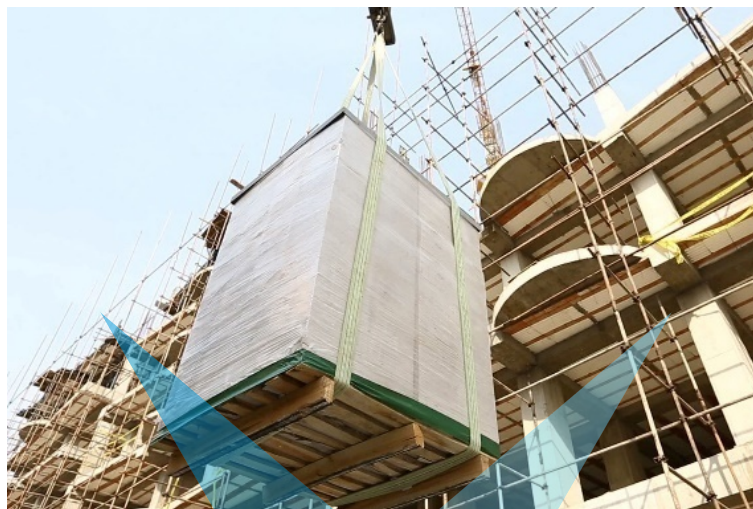
شکل ۱-۱۱- انتقال پالت‌های بلوک‌های AAC در کارگاه
