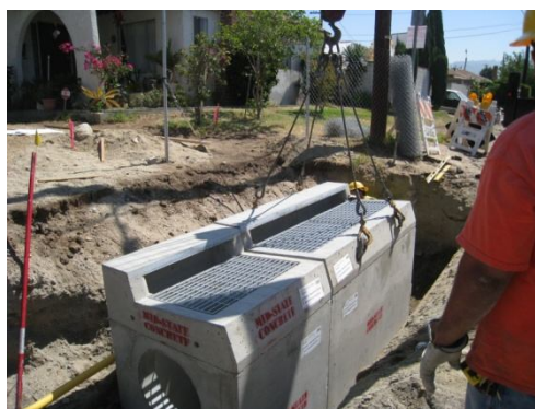
تصویر (۷/۳): تصویر آبگذر کف تیپ G نصب شده بر روی حوضچه رسوب‌گیر پیش‌ساخته
