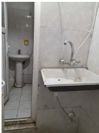
شکل پ-۸: عرض کم ورودی کابین سرویس‌های بهداشتی عمومی، وجود اختلاف سطح در سرویس‌های عمومی بازدید شده - عرض کم راهروهای داخلی (شکل پ-۹)،
