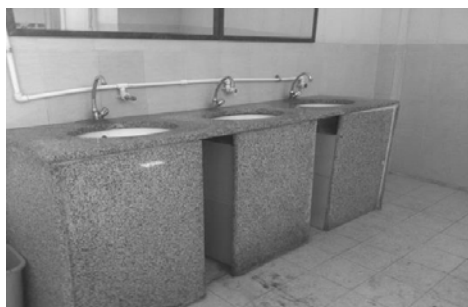
شکل پ-۹: عرض کم راهروهای داخلی در سرویس‌های عمومی بازدید شده -عدم امکان دسترسی به روشویی سرویس‌های بهداشتی برای افرادی که از صندلی چرخدار استفاده می‌کنند (شکل پ-۱۰).
