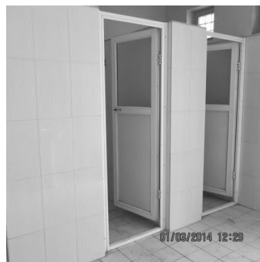
شکل پ-۸: عرض کم ورودی کابین سرویس‌های بهداشتی عمومی، وجود اختلاف سطح در سرویس‌های عمومی بازدید شده - عرض کم راهروهای داخلی (شکل پ-۹)،
