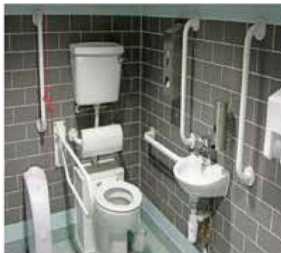
شکل ۴-۱۵: نمونه نصب میله‌های دستگرد کمکی در کابین سرویس بهداشتی افراد دارای معلولیت
