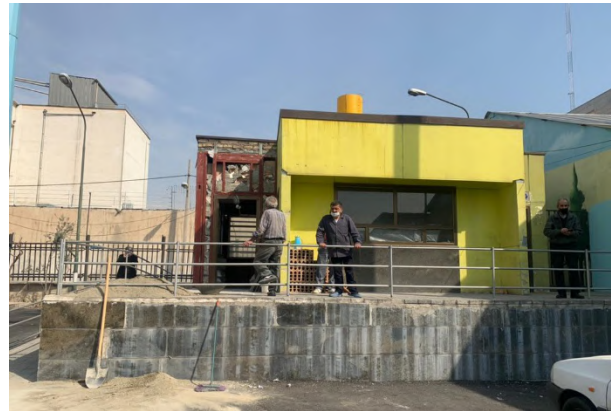
شکل پ-۱۵: سرویس‌های بهداشتی تیپ در منطقه ۱۰ شهرداری تهران با استفاده از سیستم LSF
