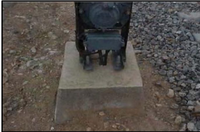
شکل ۶-۲- نمونه‌ای از فونداسیون چراغ پایه کوتاه
