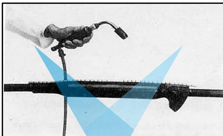
شکل ۴-۹- نحوه حرارت دادن ابتدا و انتهای کپ
