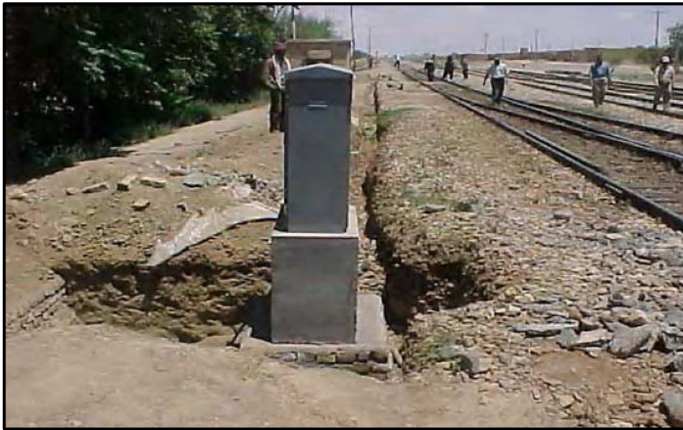
شکل ۵-۳- نمونه‌ای از فاصله فونداسیون از لبه ریل
