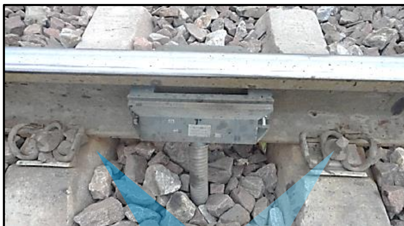
شکل ۹-۱- نمونه‌ای از نصب محور شمار
