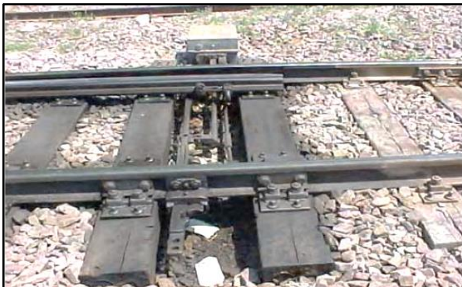
شکل ۸-۱- نمایی از یک ماشین سوزن نصب شده
