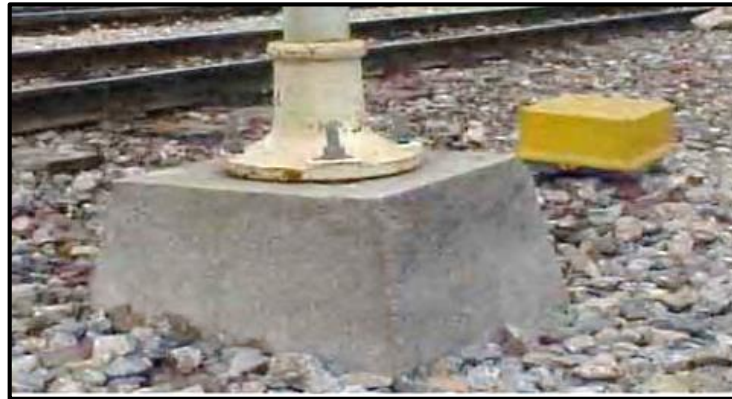
شکل ۶-۱- نمونه ای از فونداسیون چراغ پایه بلند
