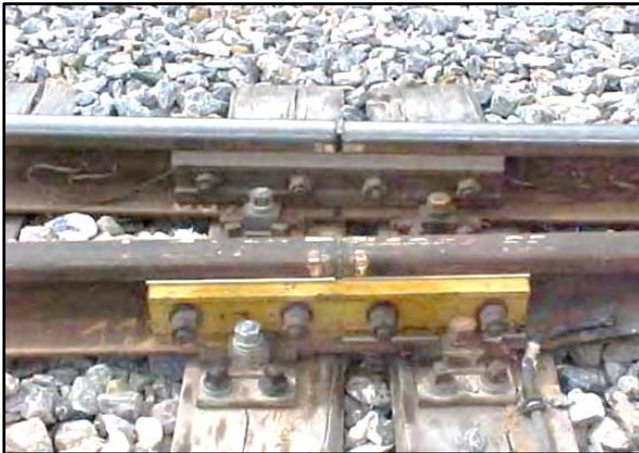
شکل ۷-۷- نمونه‌ای از عایق‌بندی
