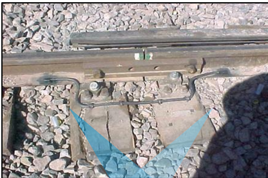
شکل ۷-۶- نمایی از یک ریل باند جوشکاری شده
