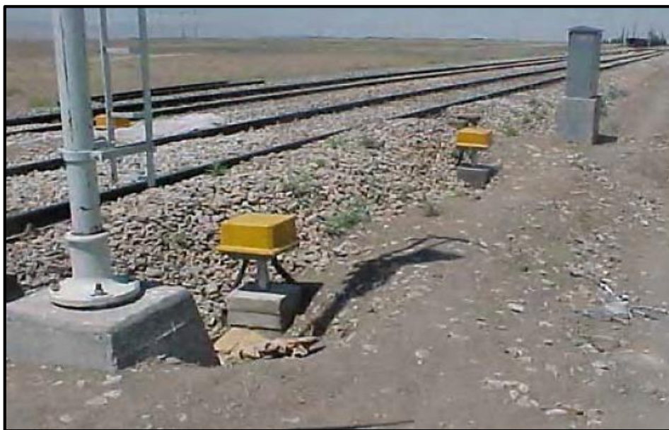
شکل ۷-۳- نمونه‌ای از نصب JB تراک و JB چراغ
