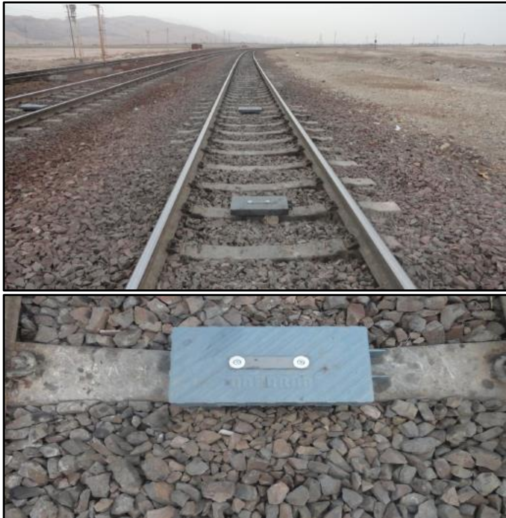
شکل ۱۰-۲- نمونه‌ای از نصب بالیزها
