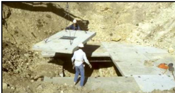
شکل ۲-۹- بستن چاه با سرپوش بتنی قابل برداشت
