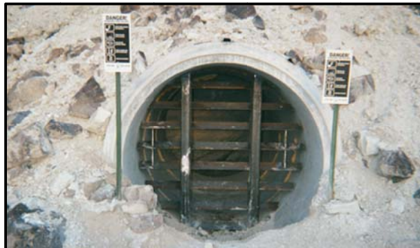
شکل ۲-۸- نمونه‌ای از دریچه فولادی برای جلوگیری از ورود احتمالی حیوانات کوچک
