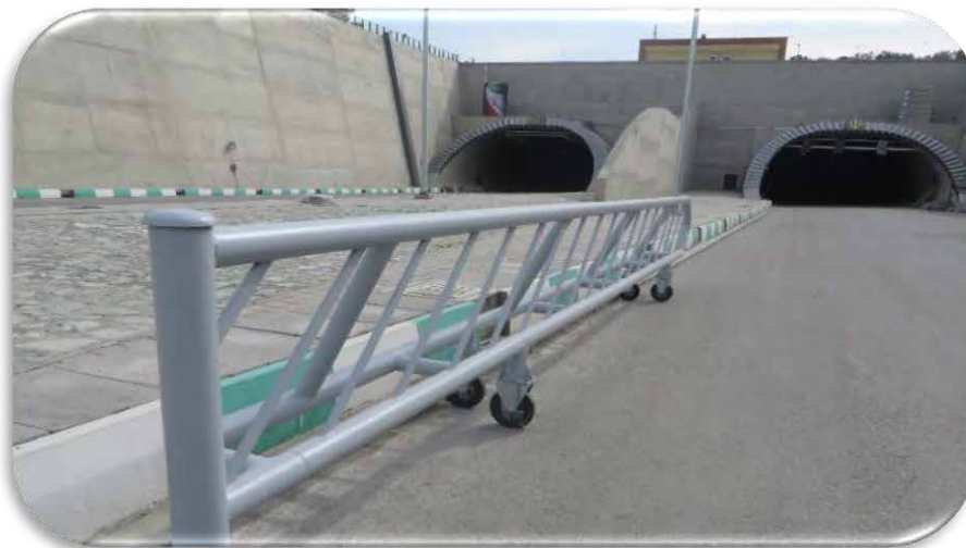
شکل ۴۴-۵: راهبند دستی با طول ۶ متر تا ۱۶ متر
