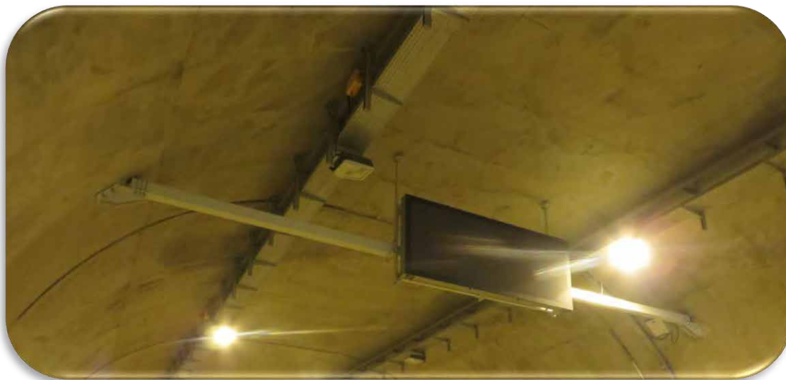
شکل ۵-۵۳: تابلوی متنی پیام متغیر خبری داخلی
