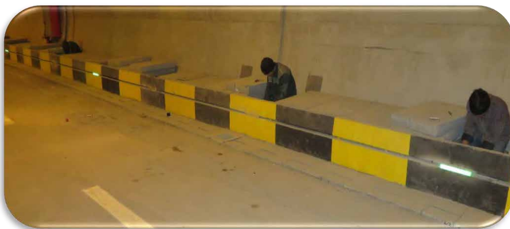
شکل ۵-۵۸: چراغ اضطراری هدایت‌کننده مسیر نصب‌شده بر روی جداول پیاده
