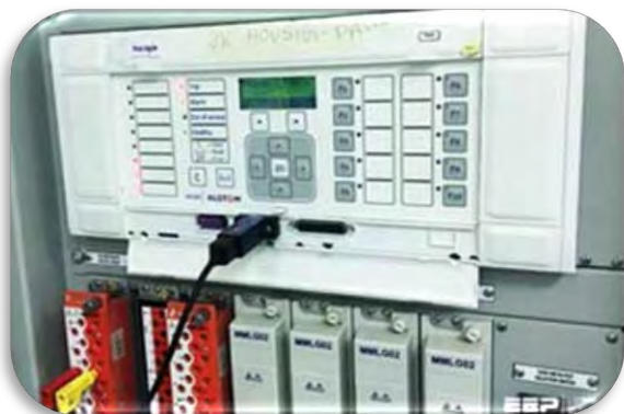
شکل ۵-۷: یک نمونه رله محافظتی در تابلو برق MCCB
