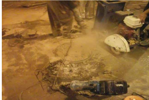
شکل ۶-۱۵: نمایی از تعمیر و رفع ایراد دریچه منهول معیوب در تونل
