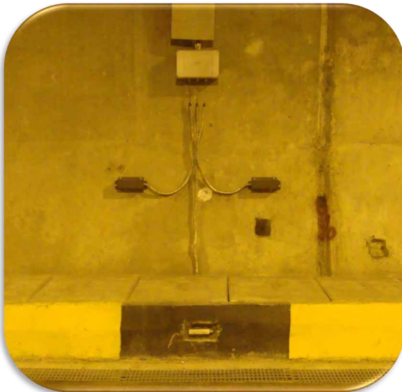
شکل ۵-۶۹: حسگر آب افتادگی
