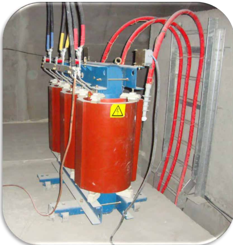
شکل ۵-۱۰: ترانسفورماتور خشک
