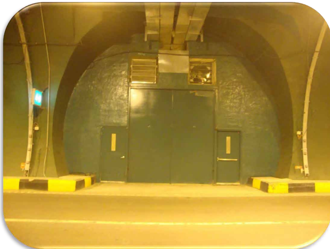
شکل ۵-۴۲: درب بزرگ تونل‌های دسترسی
