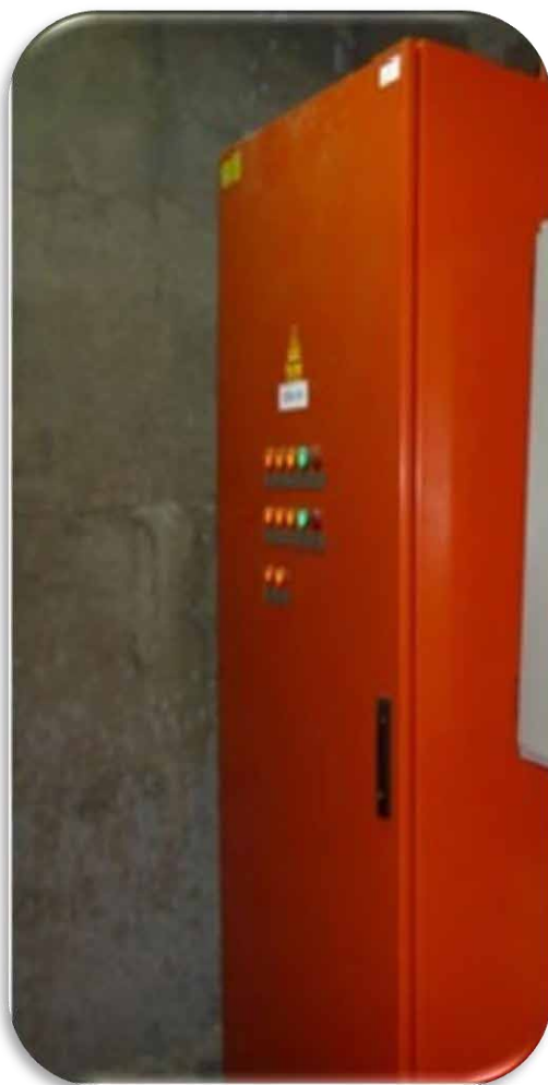
شکل ۵-۵: تابلوی ایستاده کنترل محلی سیستم‌های هوشمند حمل‌ونقل
