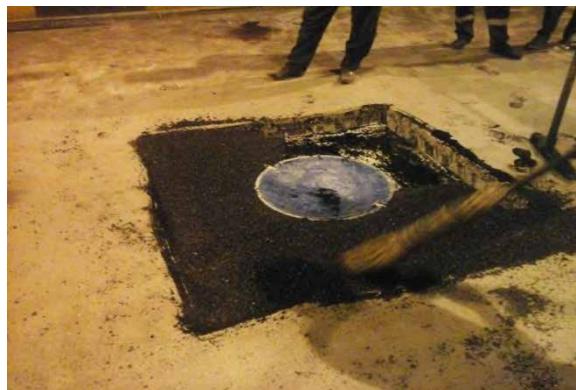
شکل ۶-۱۶: نمایی از مرمت آسفالت اطراف دریچه منهول
