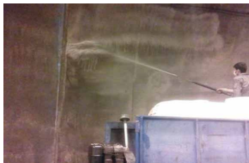
شکل ۴-۱: نمایی از شستشوی دیواره تونل توسط واترجت
