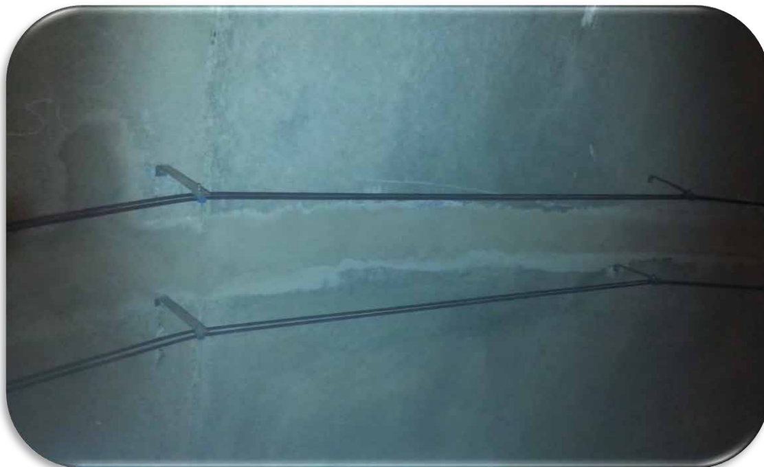
شکل ۵-۲۶: کابل تشخیص حرارت خطی
