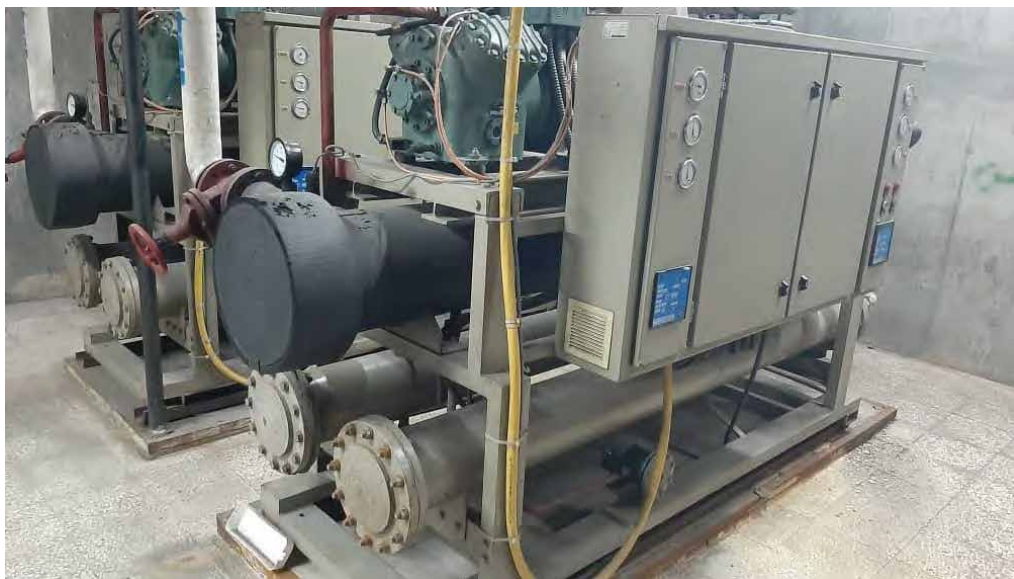
شکل ۵-۷۳: سیستم تهویه هوای مطبوع (چیلر و بویلر)
