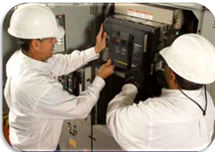
شکل ۵-۶: نمایی از قطع‌کننده مدار (بریکر)
