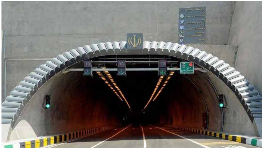
شکل ۴-۱۰: نمونه‌ای از تابلوی سرعت متغیر در ورودی تونل
