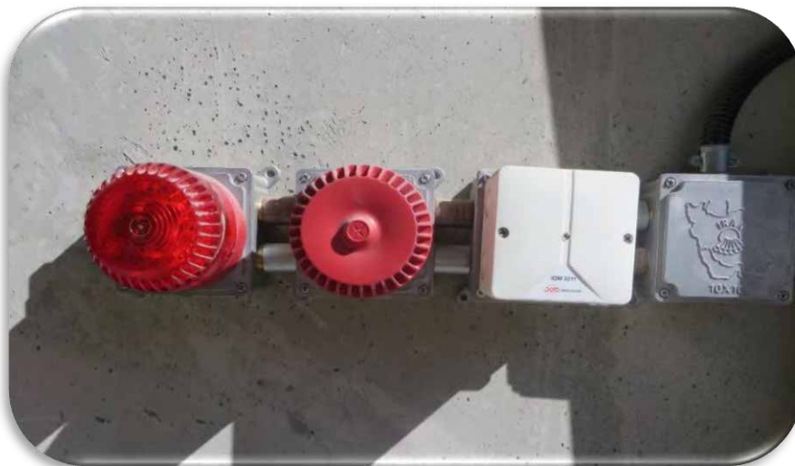
شکل ۵-۲۵: تجهیزات سیستم اعلام حریق
