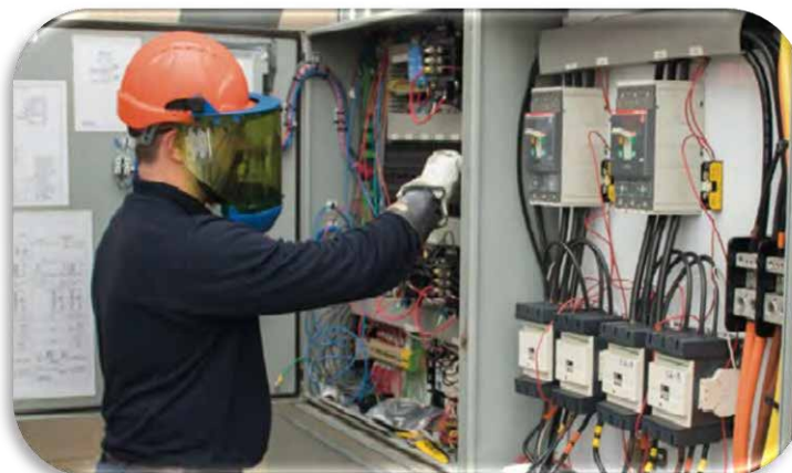
شکل ۳-۴: منابع تغذیه و تابلو برق‌ها
