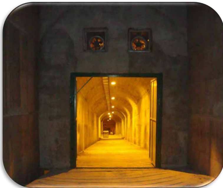
شکل ۵-۳۹: فن تونل دسترسی
