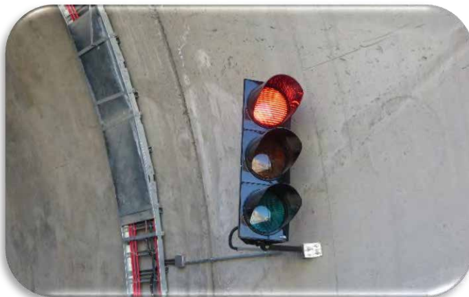
شکل ۵-۱۸: چراغ راهنمایی سه خانه
