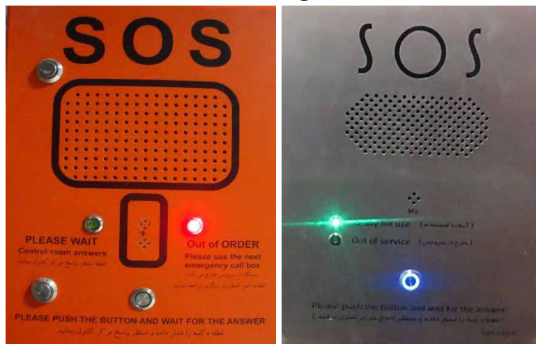
شکل ۵-۲۹: تلفن اضطراری تونل
