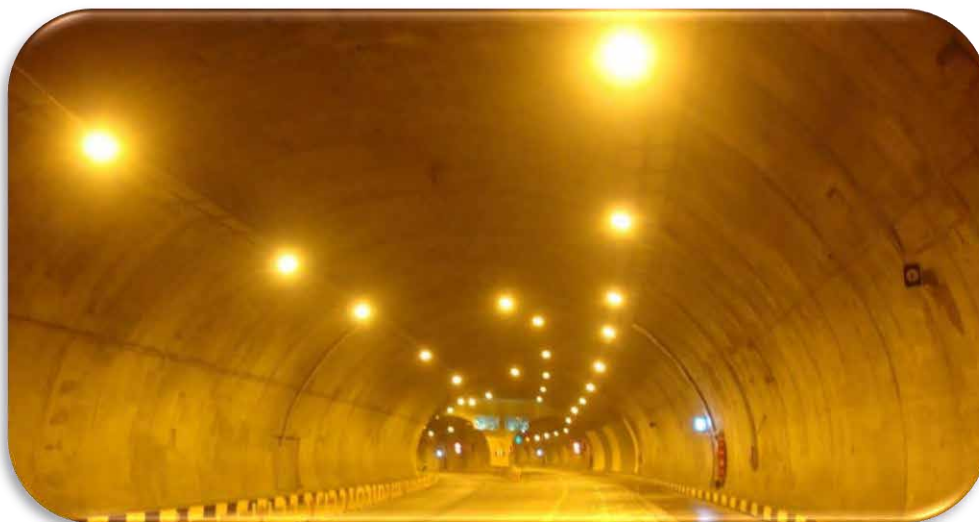
شکل ۵-۳۴: چراغ نوع بخار سدیم پرفشار
