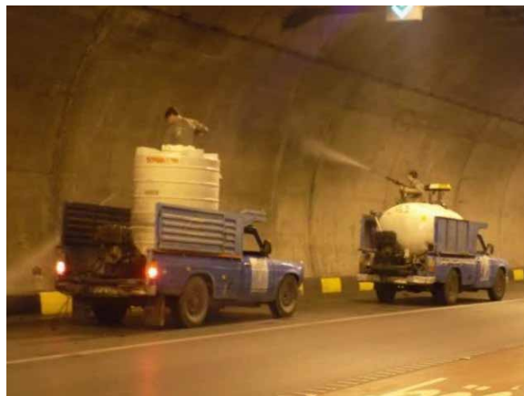
شکل ۶-۱۴: نمایی از شستشوی دیواره تونل
