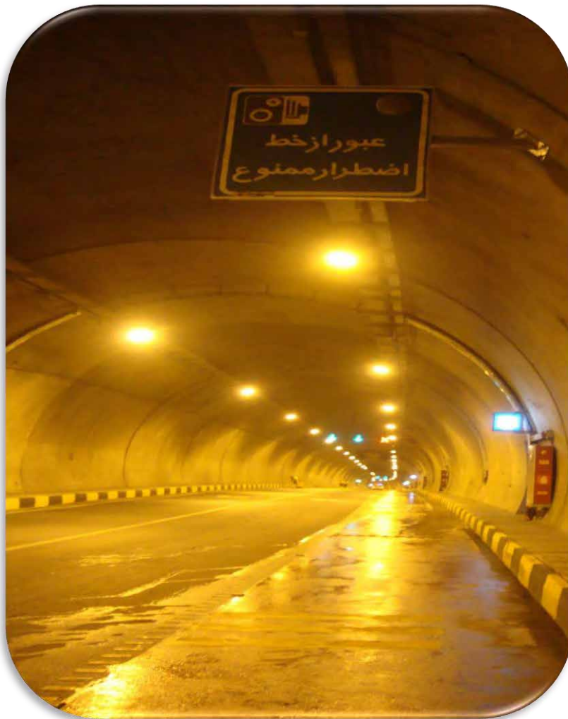
شکل ۵-۲۰: تابلی ثابت خط اضطرار
