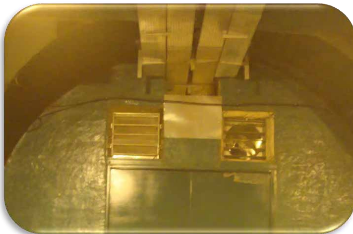
شکل ۵-۴۰: دمپر تونل دسترسی
