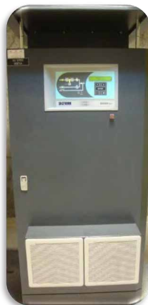
شکل ۵-۳۰: سیستم برق بدون وقفه (یو.پی.اس) سه فاز
