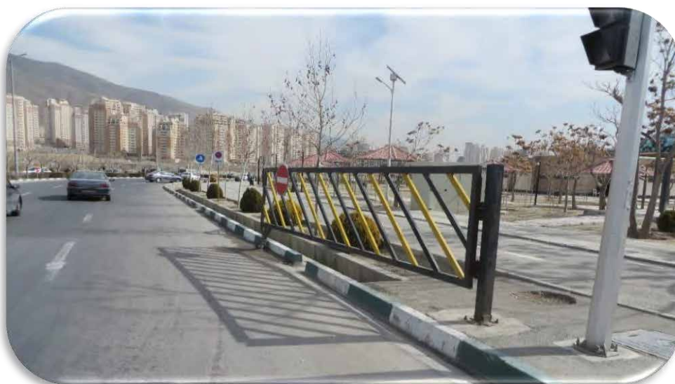
شکل ۵-۴۳: راهبند دستی با طول کمتر از ۶ متر
