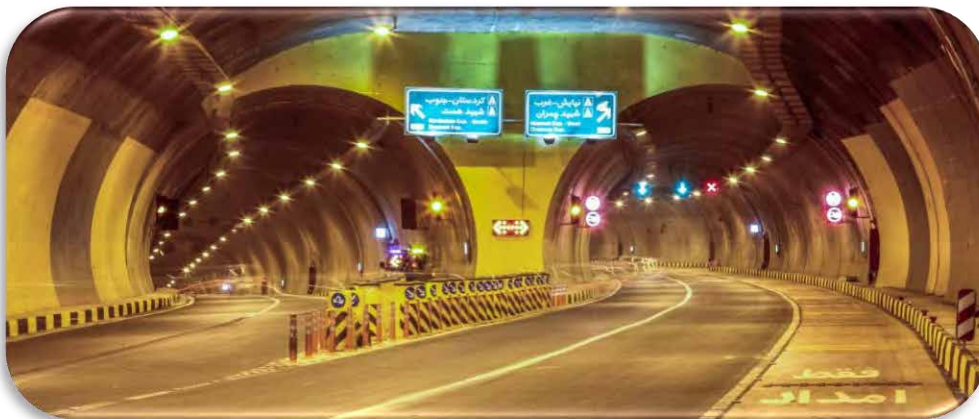
شکل ۲-۴: روشنایی در تونل‌ها
