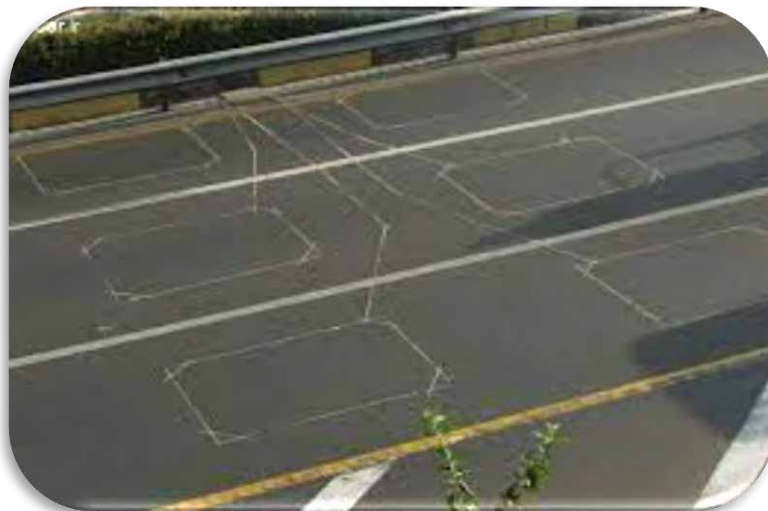
شکل ۵-۶۶: تردد شمار مغناطیسی
