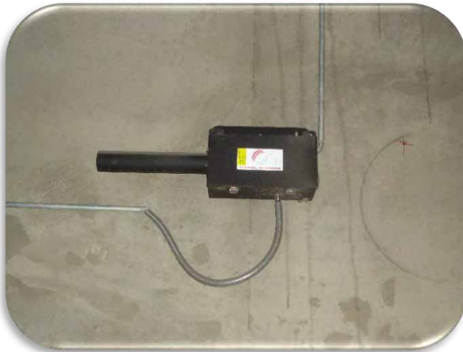
شکل ۵-۲۸: حسگر آلودگی هوای تونل
