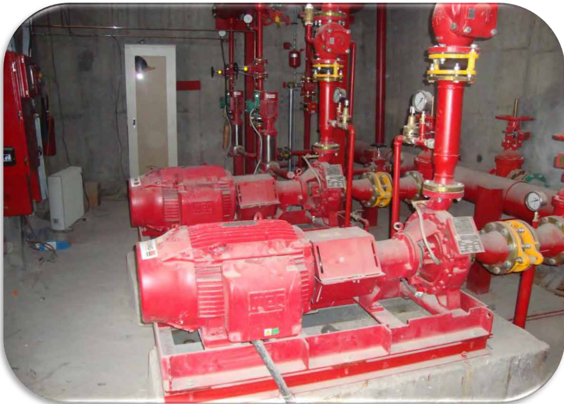
شکل ۵-۳۶: پمپ خانه بخش اطفای حریق
