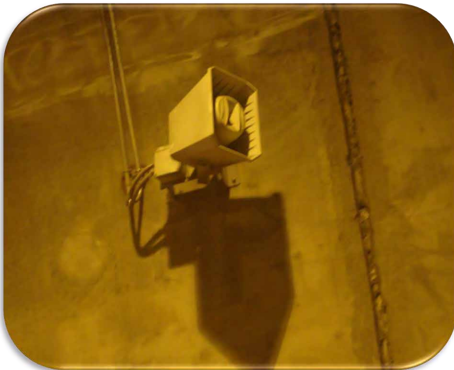
شکل ۵-۶۳: سامانه اطلاع‌رسانی صوتی
