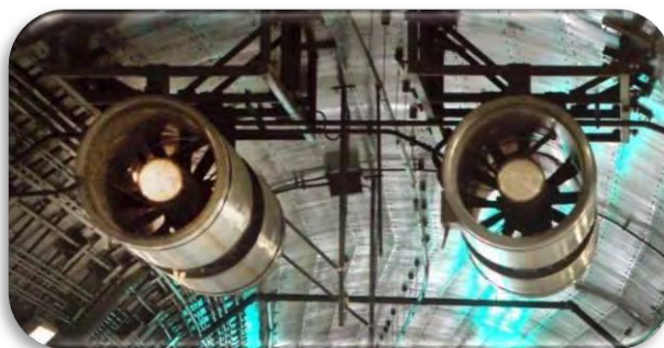
شکل ۴-۱۳: نمایی از جت فن‌های تونلی
