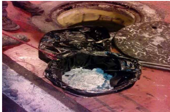
شکل ۶-۱۳: نمایی از لایروبی منهول‌ها
