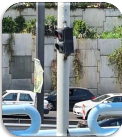
شکل ۵-۱۹: چراغ راهنمایی تکرارکننده دو خانه یا سه خانه
