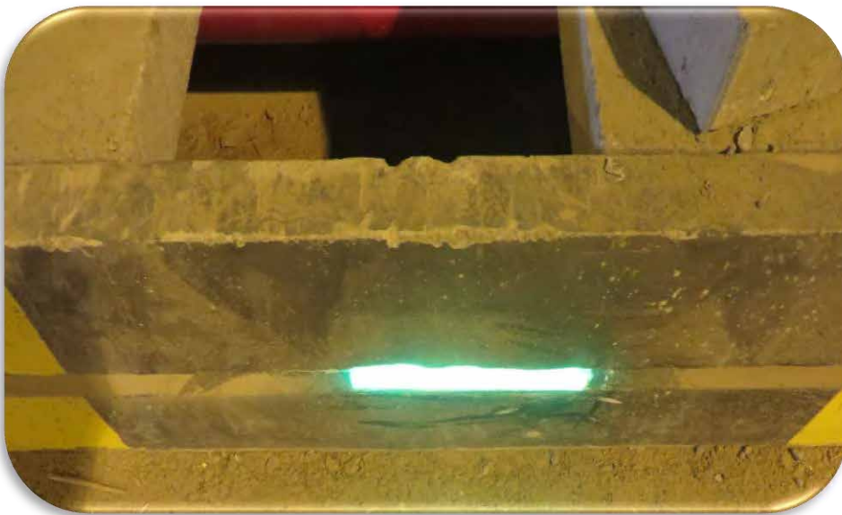
شکل ۵-۵۷: چراغ اضطراری هدایت‌کننده مسیر نصب‌شده بر روی جداول پیاده (نمای نزدیک)
