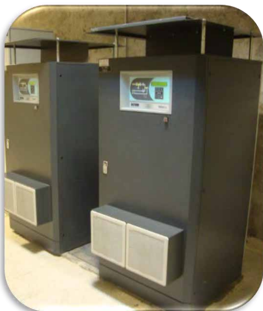
شکل ۵-۳۰: سیستم برق بدون وقفه (یو.پی.اس) سه فاز
