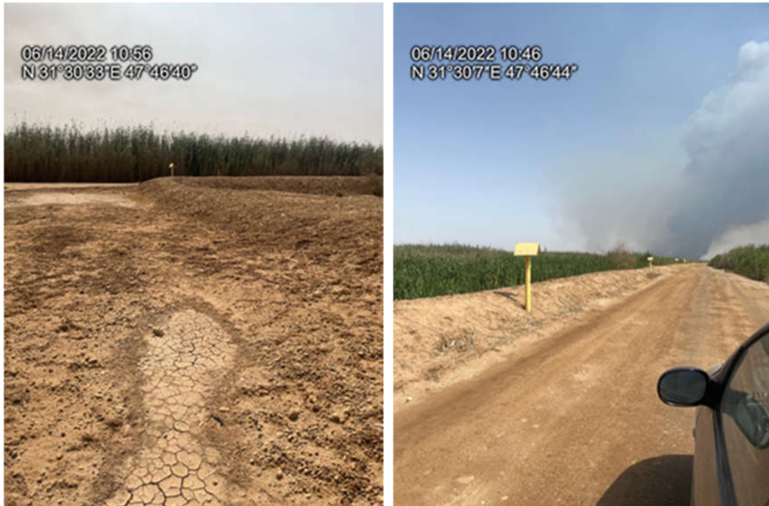
شکل ۳-۴: خطوط لوله مدفون اجرا شده در کنار جاده
