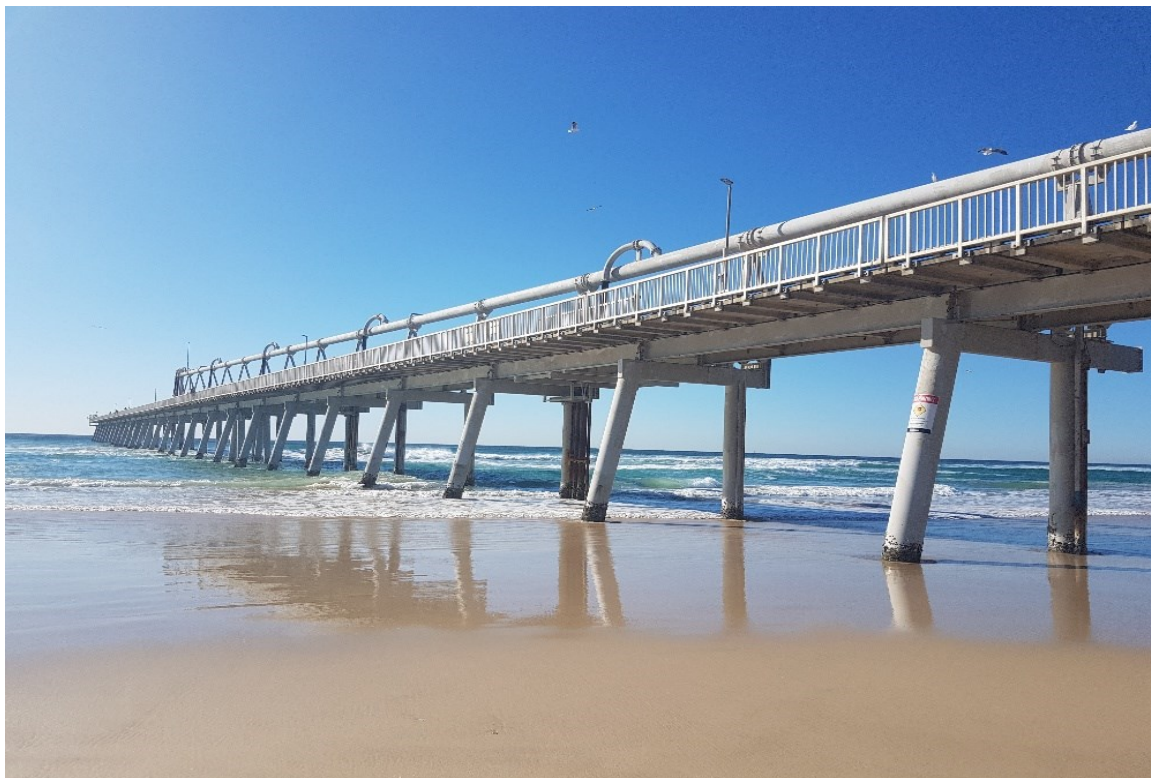
شکل ۲-۱۳- نمایی از تجهیزات برداشت رسوبات در سیستم گذردهی رسوب رودخانه نرنگ شامل پلتفرم شمع و عرشه و جت پمپ‌ها با وظیفه به دام اندازی رسوب، مکش و انتقال مخلوط آب و رسوب
