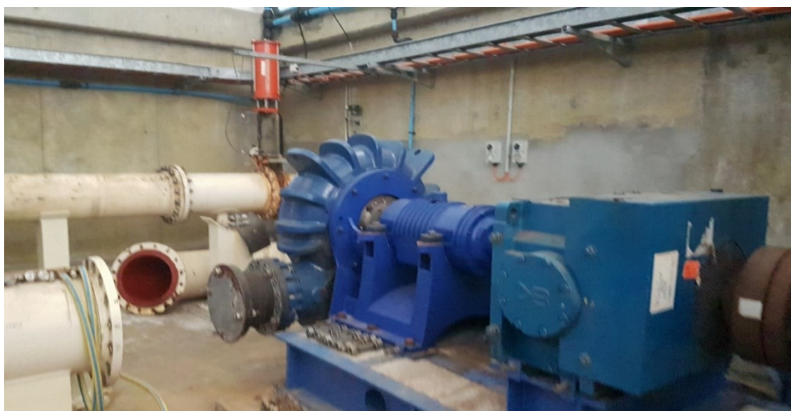
شکل ۲-۷- نمایی از پمپ‌های اسلاری مورد استفاده در سیستم گذردهی رسوب رودخانه توئید
