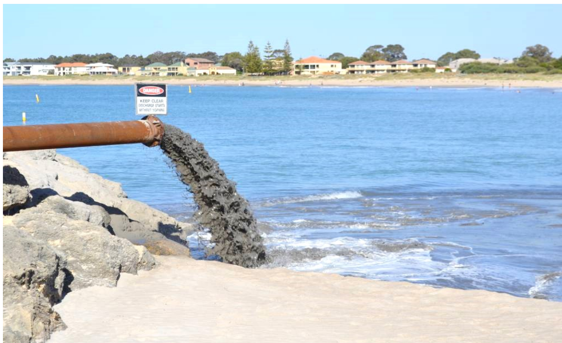
شکل ۷-۱- نحوه تخلیه مخلوط آب و رسوب
