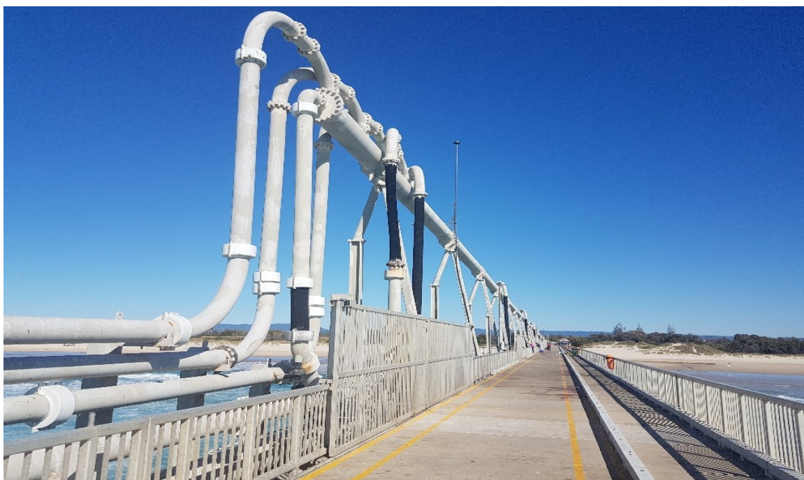
شکل ۲-۱۴- نمایی از روی عرشه پلتفرم شمع و عرشه (جهت تصویر از طرف دریا به طرف خشکی). در این شکل مسیر انتقال مخلوط آب و رسوب از جت پمپ‌ها به لوله انتقال به خشکی به خوبی دیده می‌شود
