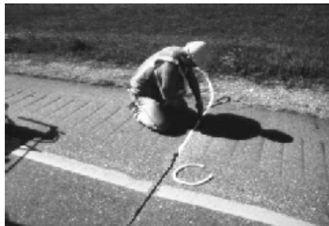
شکل ۳- نصب دستی میله باربر
