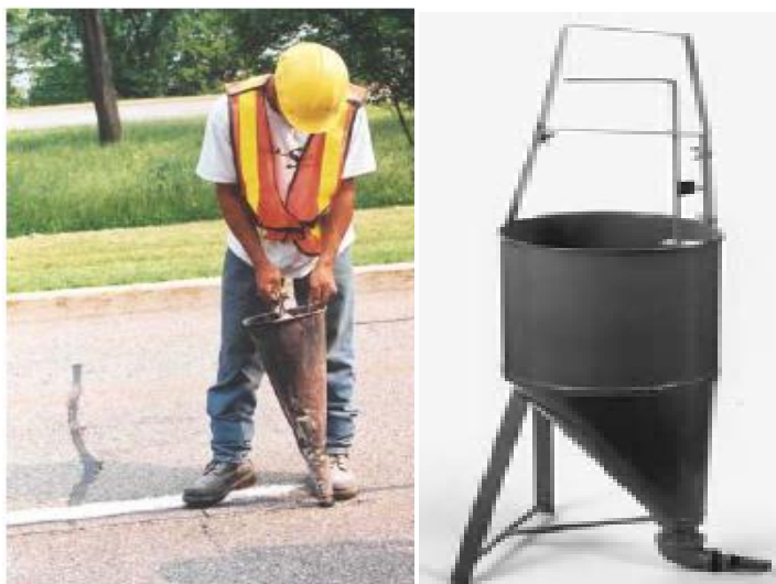
شکل ۶- ابزارهای ریختن قیر امولسیون
