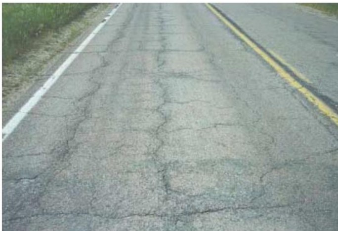
شکل ۳- ترکهای بلوکی
