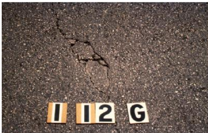
شکل ۲- ترک اولیه همراه با ترک ثانویه
