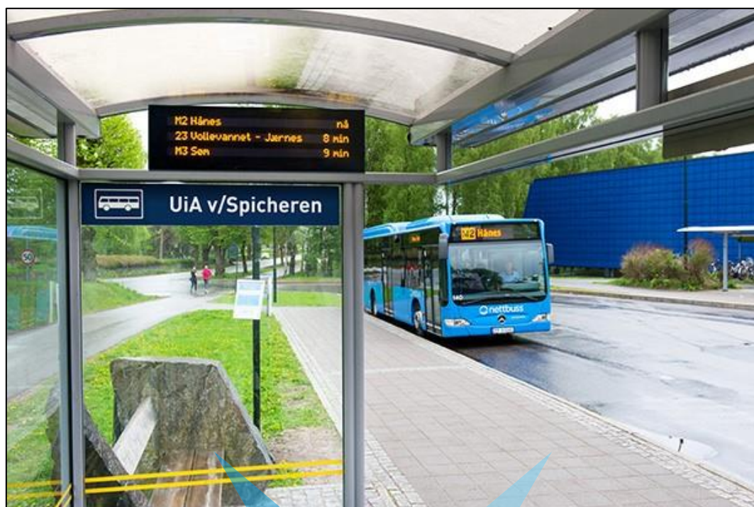
شکل ۷-۹- نمونه تابلوهای پیام متغیر در داخل یک ایستگاه همگانی
