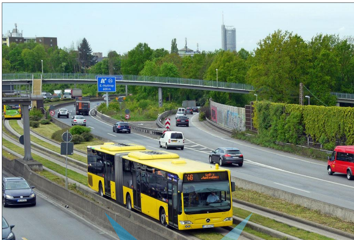
شکل ۱-۱۶- مسیر ویژه سیستم هدایت مکانیکی اتوبوس
