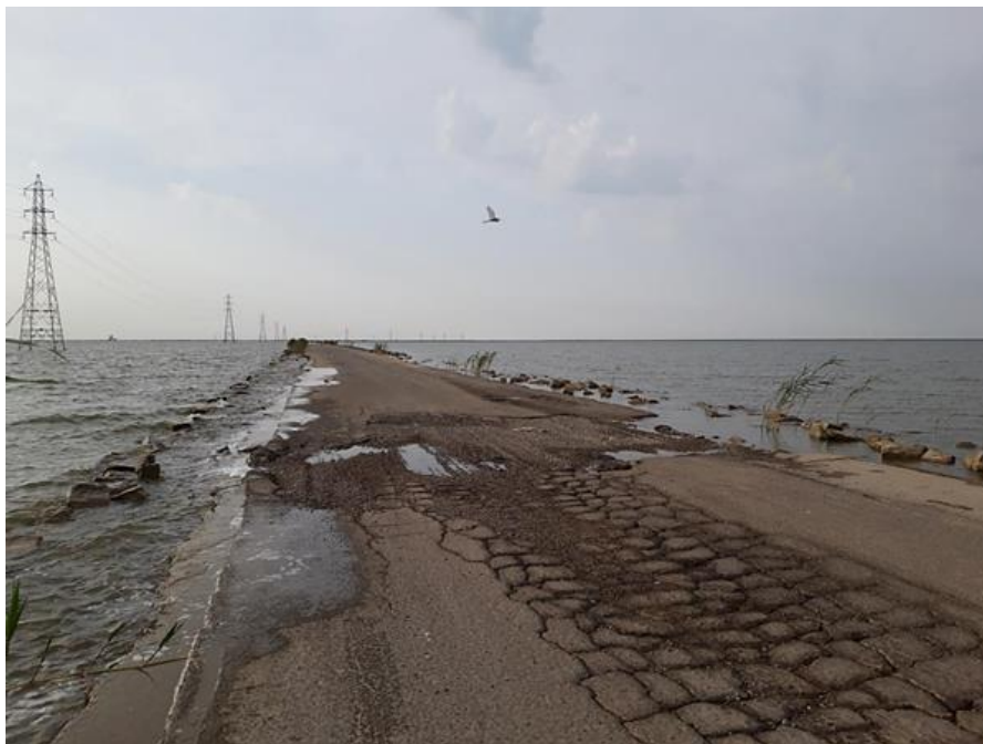
شکل ۴-۵ نشست‌های انتقال یافته به روسازی جاده و تخریب آن در جاده یاران شمالی
