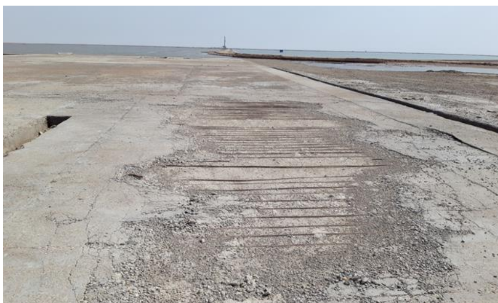
شکل ۳-۵ از بین رفتن پوشش بتنی روسازی محوطه سله در میدان نفتی آزادگان جنوبی
