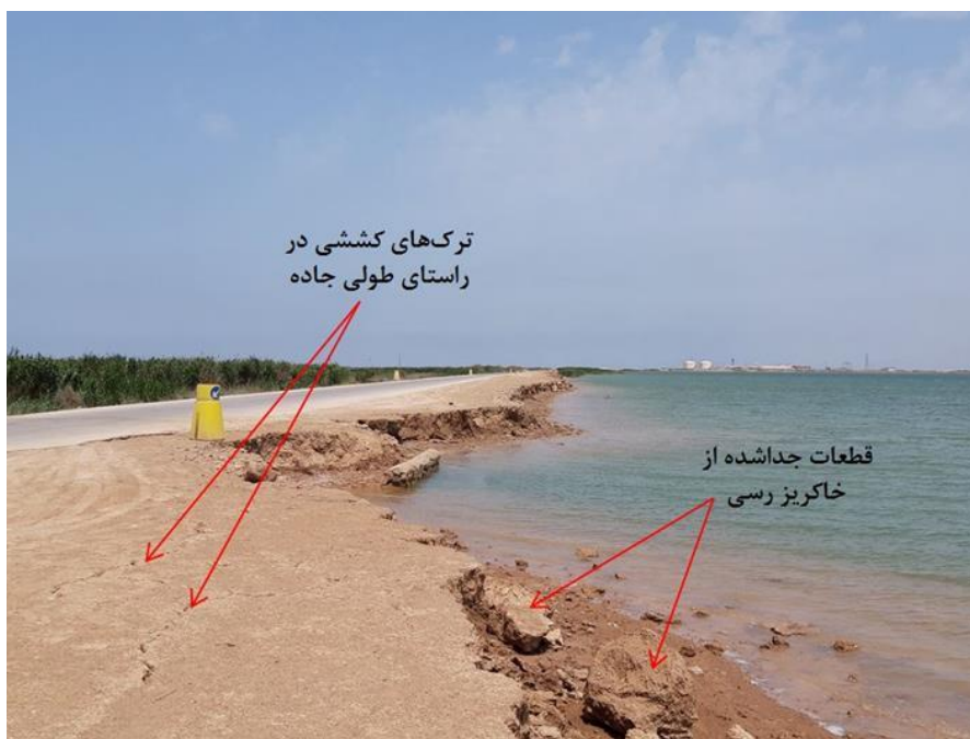
شکل ۷-۴ وقوع ترک‌های کششی طولی در سطح خاکریز تعریض شده جاده اکتشاف
