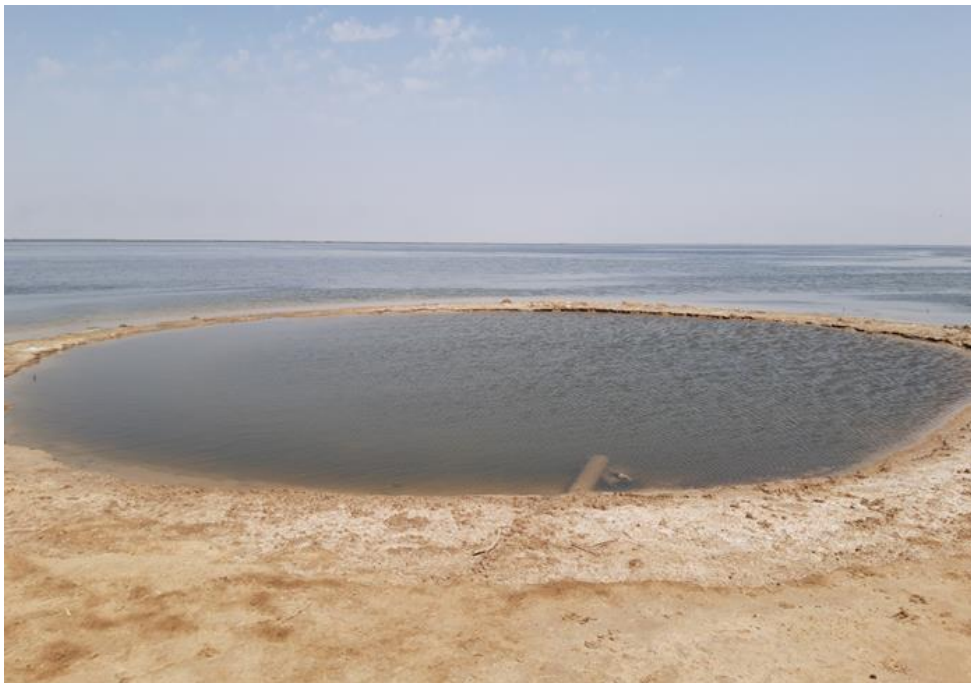
شکل ۴-۵ استغراق خاکریز رسی گودال سوخت به دلیل پایین بودن تراز خاکریز آن
