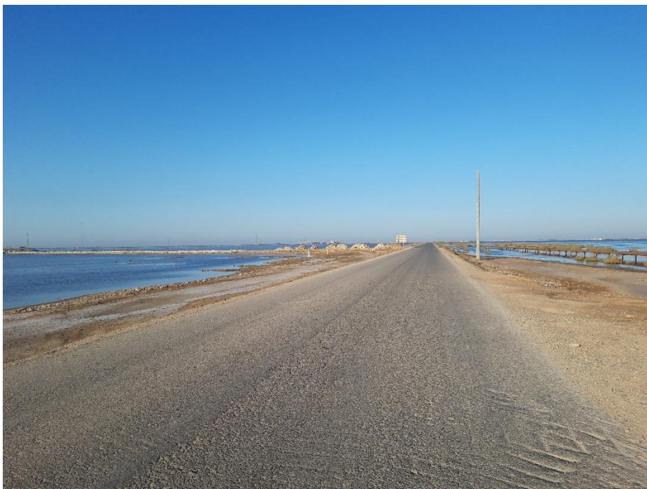
شکل ۳-۱ یک نمونه از جاده‌های اصلی موجود در منطقه با روسازی آسفالتی (جاده شهید همت)
