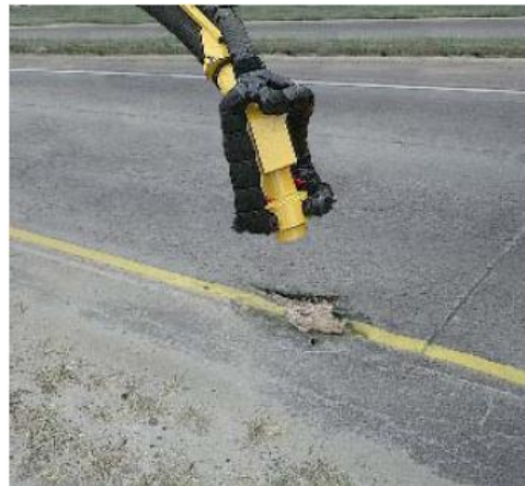
شکل ۳-۳- تمیز نمودن چاله جهت ترمیم
