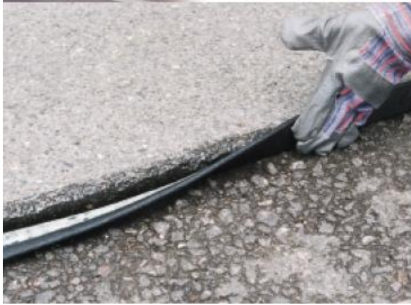
نصب نوار لکه‌گیری بر روی دیواره آسفالت
