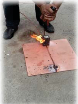
فرایند آگزوترمیک (حرارت دهنده)
