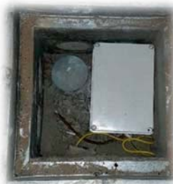
قرارگیری باکس شیشه اصلی و کابل مسی و نصب درپوش لوله پلیکا
