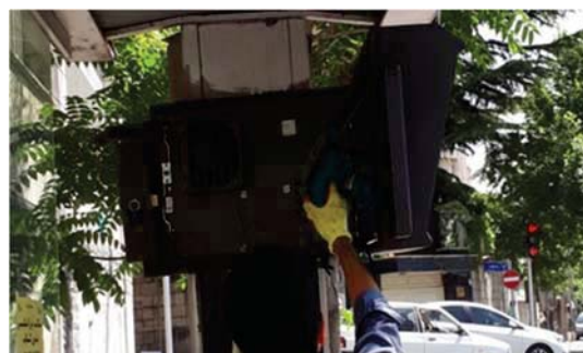
شکل ۴-۲: نظافت و بادگیری بدنه و تجهیزات داخلی نمایشگر
