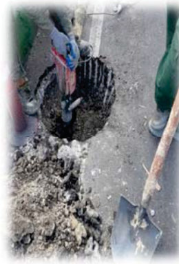
عملیات حفر چاه
