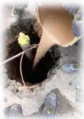
قرار دادن لوله پلیکا و ریختن دوغاب بنتونیت
