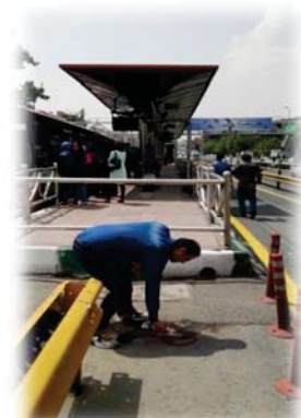
علامت گذاری محل احداث چاه
