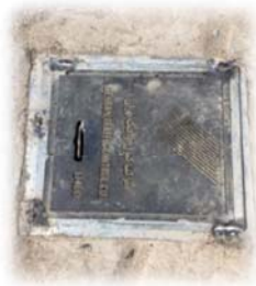
جوش‌کاری درب دریچه بازدید
