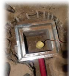
قرار دادن دریچه بازدید بالای چاه
