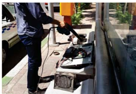
شکل ۴-۲: نظافت و بادگیری بدنه و تجهیزات داخلی نمایشگر
