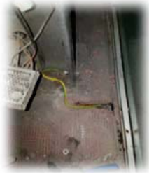
نصب شینه اصلی ارت داخل باکس و اتصال انشعاب اصلی و سایر انشعابات به آن
