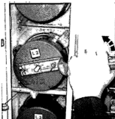
شکل ۴-۱۲۴ مراحل تعویض فیوز
