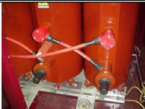
شکل ۴-۵ پوشینگ ترمینال فشار قوی
