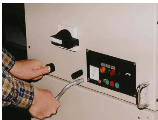
شکل ۱۹- تغییر وضعیت کلید به Disconnect
