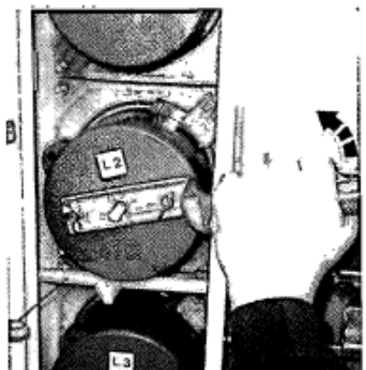
شکل ۴-۱۱۶ مراحل تعویض فیوز
