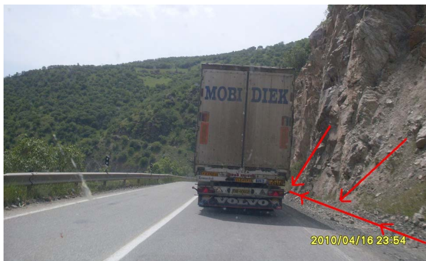
شکل پ ۱-۱- عدم وجود سیستم زهکشی طولی مناسب برای هدایت روان آب
