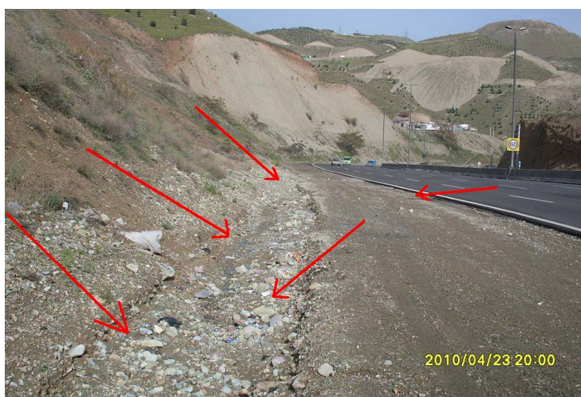
شکل پ-۱-۶- عدم وجود سیستم زهکشی طولی مناسب (عدم هدایت روان آب سرازیر شده از ترانشه ها و سطح راه)
