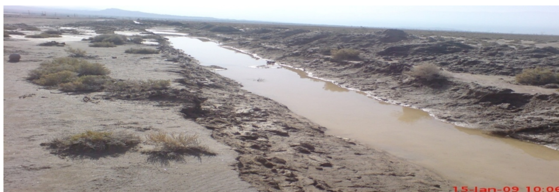
شکل پ ۱۲-۱- کانال زه کشی طولی اصلاح شده که دارای عملکرد بهتر می باشد.
