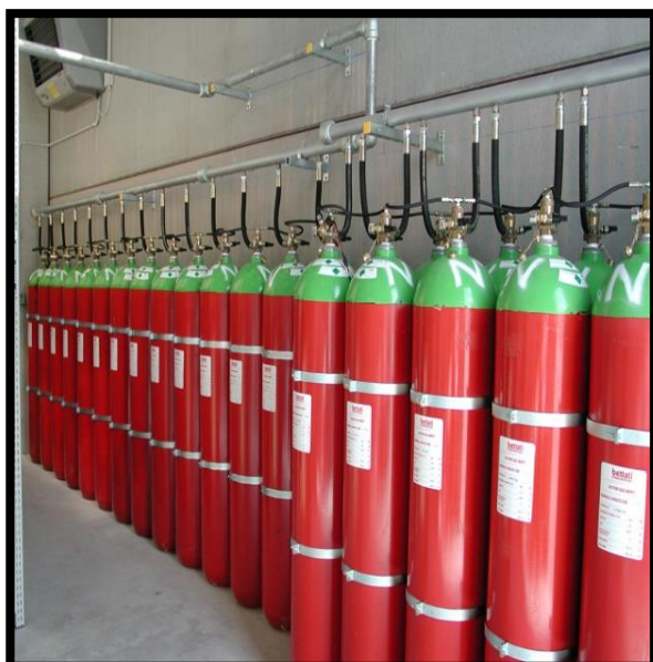
شکل ۴-۲ سیلندرهای اطفای گازی
