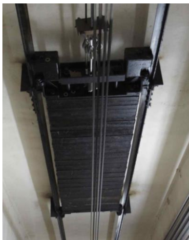
نمایی از قاب وزنه و وزنه‌های تعادل
