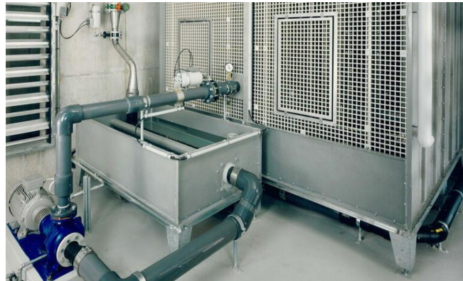
شکل ۳-۴-۱ حوضچه هواسازهای ایستگاهی و تونلی
