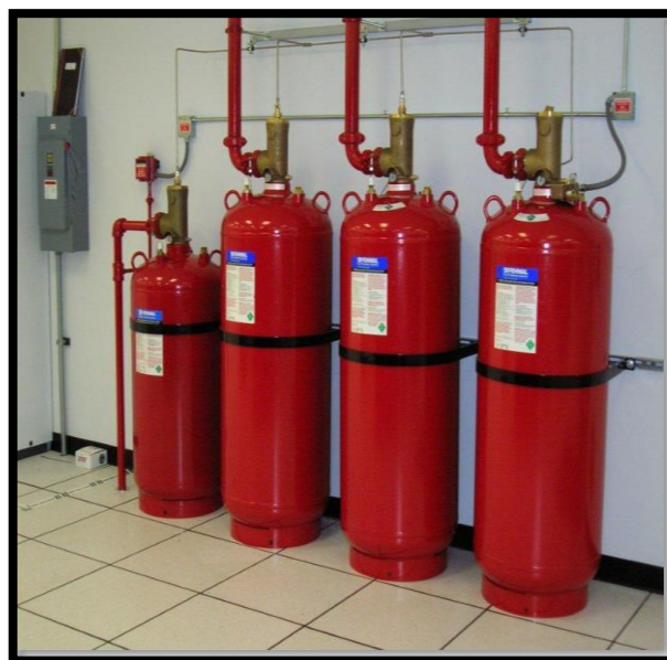
شکل ۴-۲ سیلندرهای اطفای گازی
