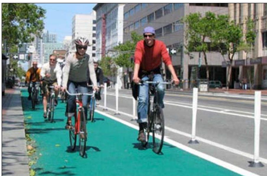
شکل ۴-۴- جداسازی مسیر درجه ۱ از سواره‌رو با استفاده از استوانه‌های ارتجاعی
