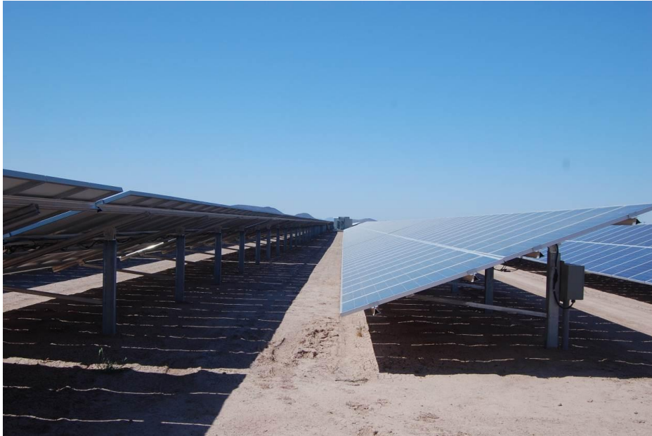
شکل ۵- نمونه نیروگاه با آرایه با شیب ثابت
