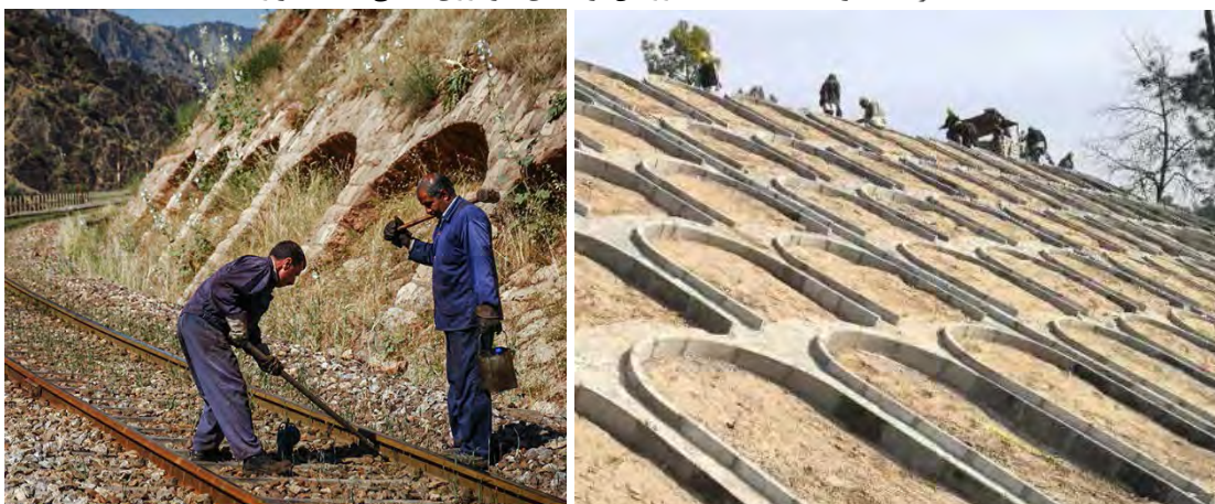
نگاره ۳۸: تثبیت ترانشه با قاب‌بندی، راست: بزرگراه حاولیان، کراچی پاکستان، چپ: راه آهن لرستان
