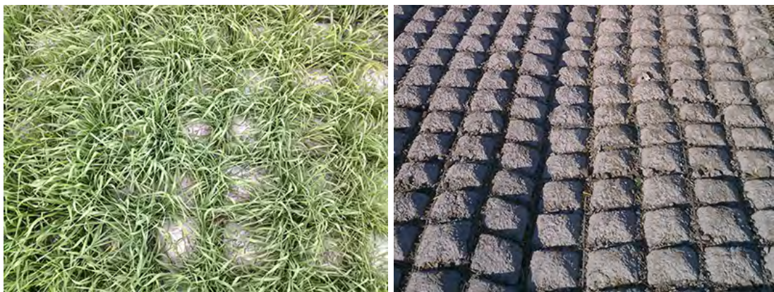
نگاره ۳۶: استفاده از شبکه زیرین و اجرای خشکه‌چین Rip-rap در همخوانی با طبیعت
