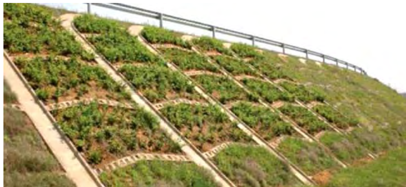
نگاره ۴۰: حفاظت از شیب تند زیر پل با ترکیب کاشت و شبکه بندی، پل شانگ شینگ چین
