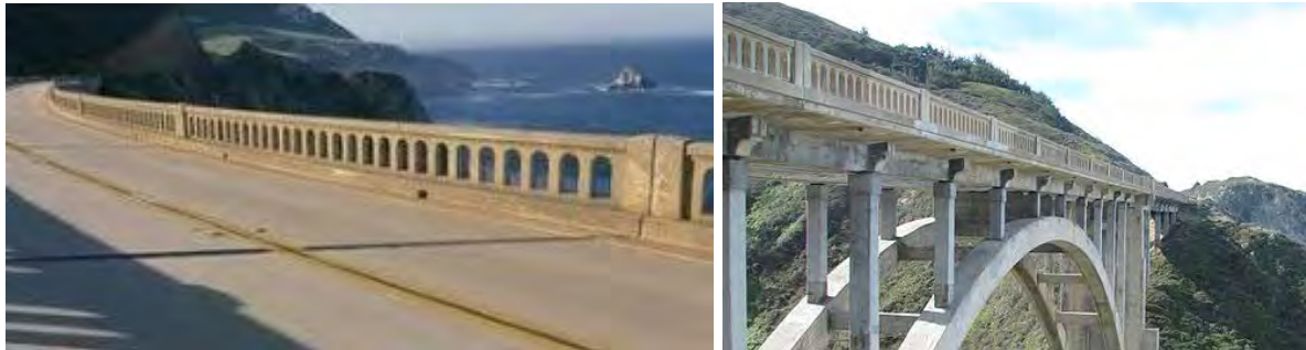
نگاره ۶۵: حفظ دید به منظر با طرح متخلخل حفاظ بتنی، پل بیکسبی، کالیفرنیا
