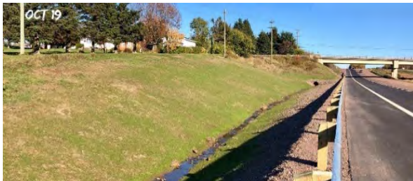
نگاره ۱۷۲: تثبیت ترانسه و راه آب آزهکش طولی به روش بذرپاشی دوغابی
