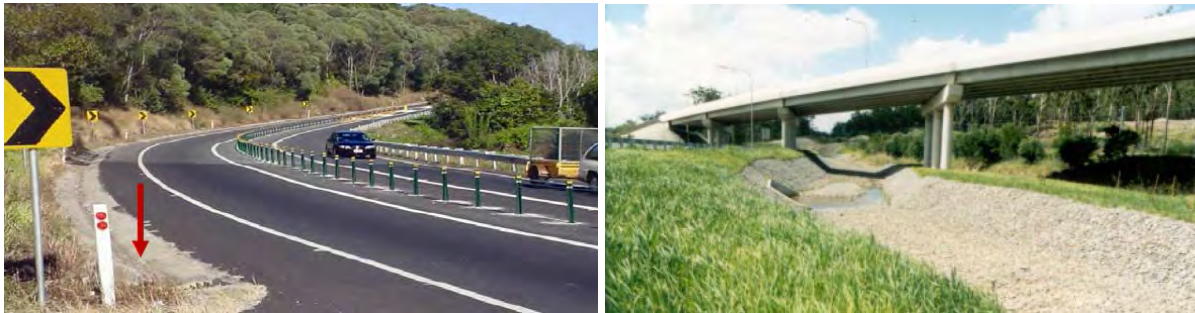
نگاره ۸۳: راست: آبروی خطی با بستر پوشیده از سنگ، استرالیا؛ چپ: کانیو ۱ جمع‌آوری آب سطح جاده پاسیفیک، نیوولز جنوبی استرالیا
