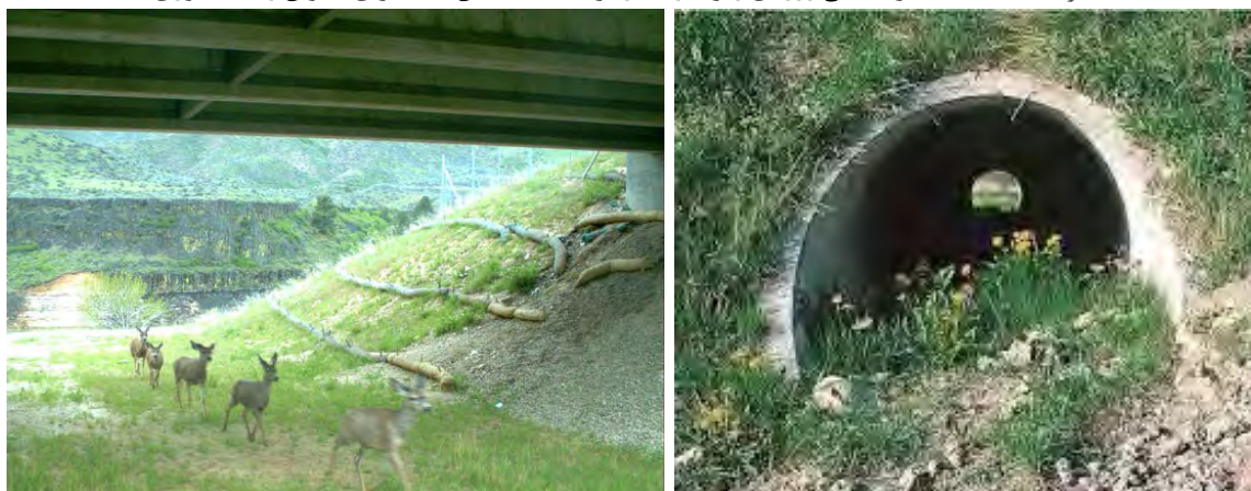
نگاره ۱۵۷: راست: پرشدن زیرگذر از ریزش خاک، چپ: کنترل شستگی خاک زیرگذر با چینش کیسه‌های خاک سرعتگیر سیلاب
