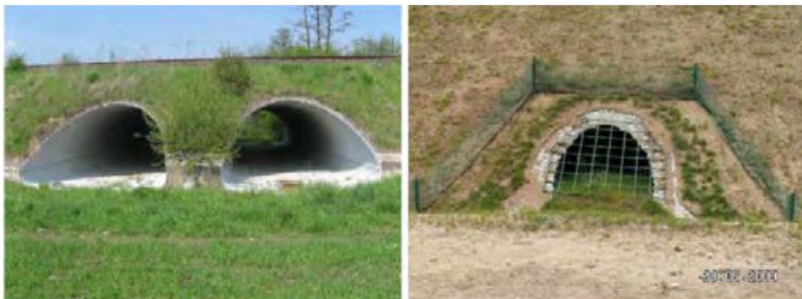
نگاره ۱۵۶: حفظ ظاهر طبیعی ورودی زیرگذرها در ترکیب با گیاهان آشنا برای حیوان و نصب توری
