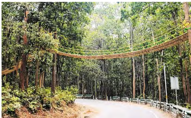
نگاره ۱۵۱: تامین عبور ایمن خزندگان و حیوانات کوچک از روی جاده، هند
