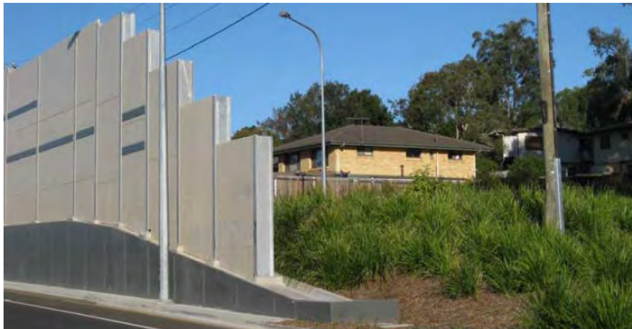
نگاره ۴۷: نمونه تعریف ابتدای دیوار با افزایش پلکانی ارتفاع
