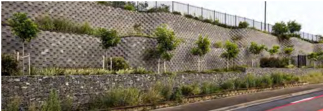
نگاره ۵۷: نمونه دیوار حائل ترکیب گابیون و بتن پیش ساخته، استرالیا
