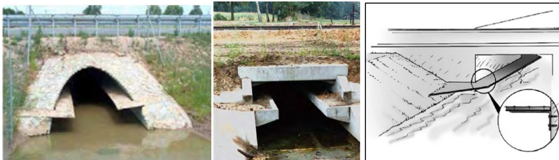
نگاره ۱۵۵: اتصال تخته به عنوان زیرگذر حیوانات آب ترس
