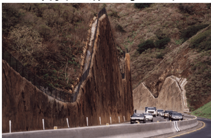
نگاره ۴۴: اجرای دیوار با شمع و با فرم و نمای طبیعی، جنوب شرق آسیا
