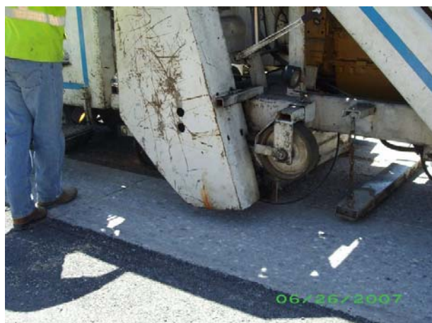
ذ- عملیات سایش
