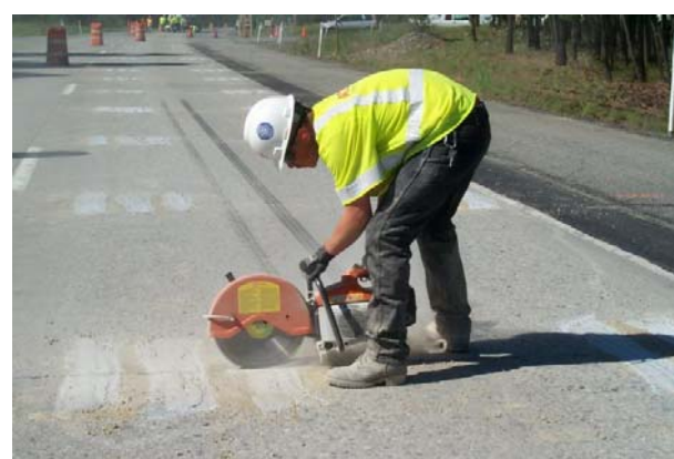
د- اړه‌کاری در محل شیارهای پر شده
