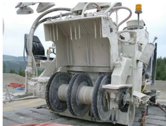
الف- ایجاد شیار برای جای‌گذاری میلگرد انتقال بار
