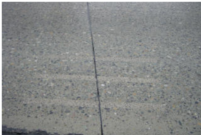
شکل ۴-۲۹- وضعیت سطح روسازی پس از عملیات تقویت با میلگرد انتقال بار
