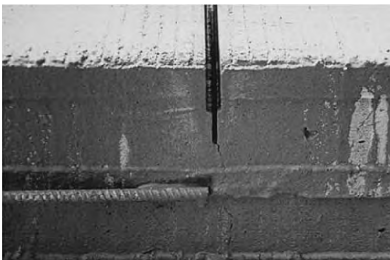
شکل ۳-۶- برش اولیه و ثانویه (پهن) در درز عرضی
