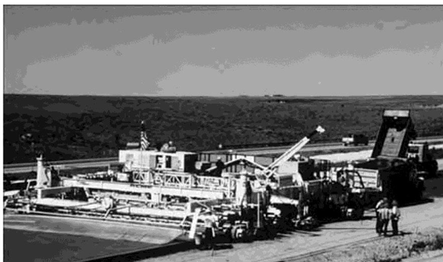
شکل ۳-۲۱- مجموعه تجهیزات اجرای روسازی به روش قالب لغزنده
