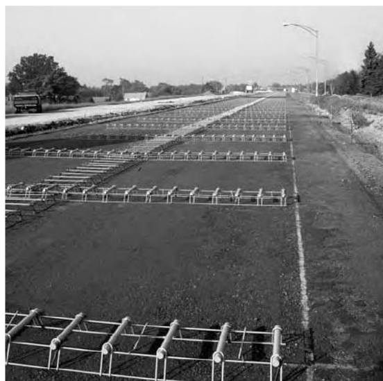
شکل ۳-۳- مجموعه سبدهای میلگردهای انتقال بار
