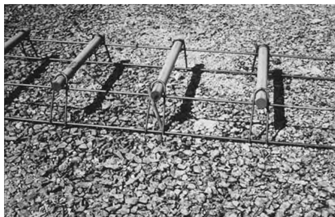
شکل ۳-۲- سبد میلگردهای انتقال بار
