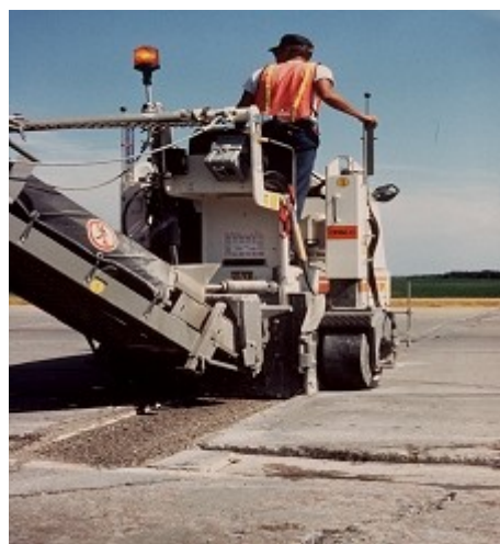
شکل ۴-۱۹- ماشین تراش کاربیدی برای تراش بتن
