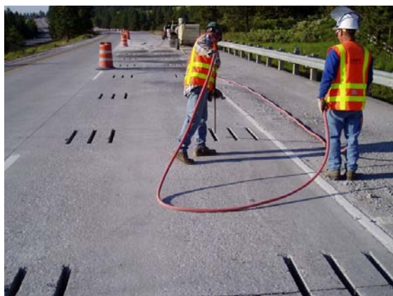
ب- تمیز کردن محل قرارگیری میلگردهای انتقال بار
