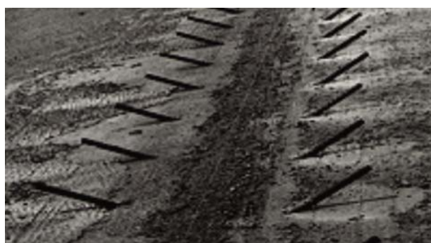
ث- قراردادن میلگردهای دوخت در سوراخ‌های حاوی اپوکسی (در این شکل میلگردها هنوز به‌طور کامل جای‌گذاری نشده‌اند)
