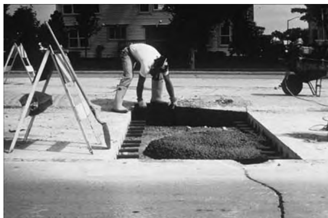
شکل ۴-۲۶- وصله عمقی با میلگرد اتصال و صفحه پیوندزا
