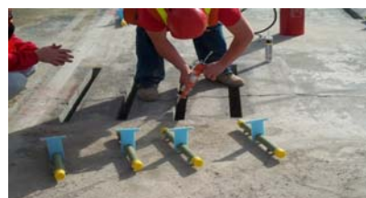
الف- ایجاد شیار برای جای‌گذاری میلگرد انتقال بار
