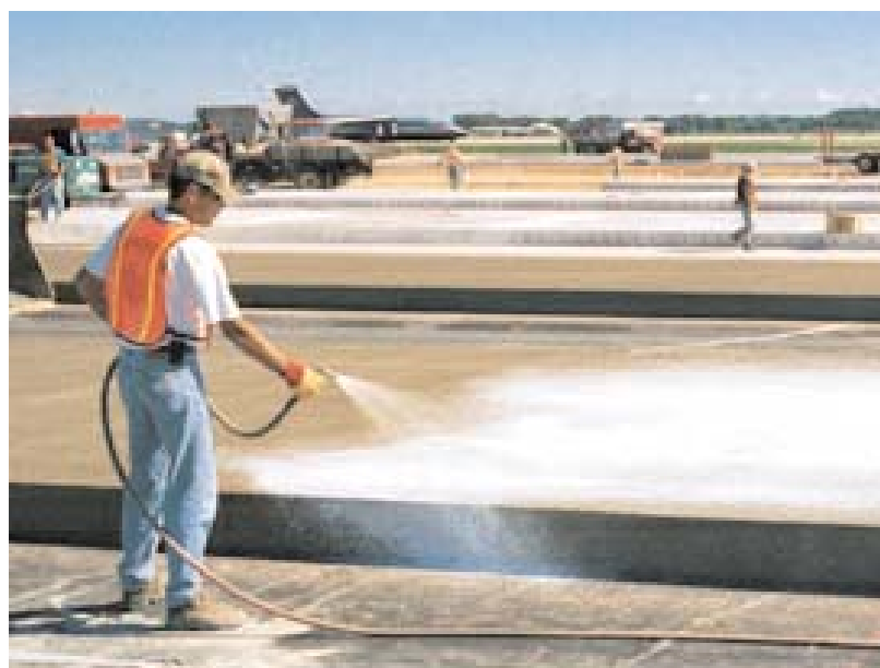
شکل ۳-۴۳- پاشش ماده عمل‌آوری به‌صورت دستی
