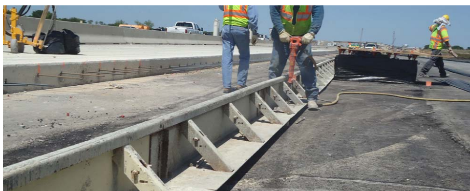
شکل ۳-۲۹- مهار قالب به لایه زیرساز
