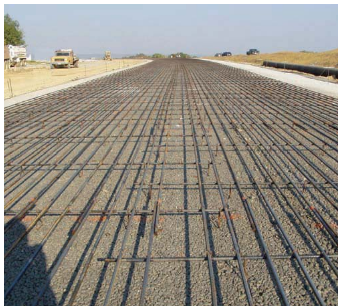
شکل ۱-۱۰- نصب میلگرد در روسازی بتنی مسلح پیوسته
