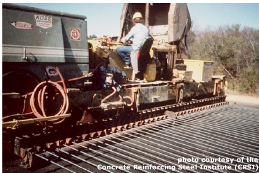
شکل ۵-۳- نصب میلگردهای روسازی بتنی مسلح پیوسته با استفاده از تغذیه کننده لوله‌ای
