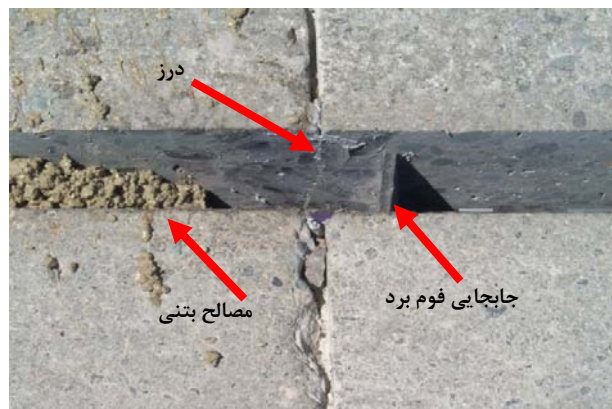
ج- جابجایی فوم برد هنگام تخلیه بتن در محل شیار
