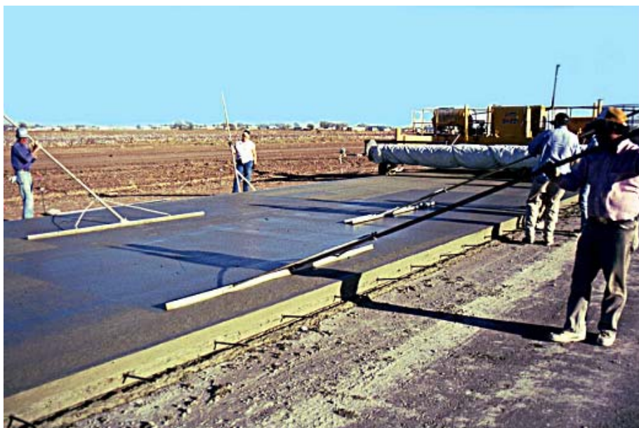
شکل ۳-۳۳ - شمشه دستی - هنگام کشیدن شمشه، دسته آن بالا قرار می‌گیرد.
