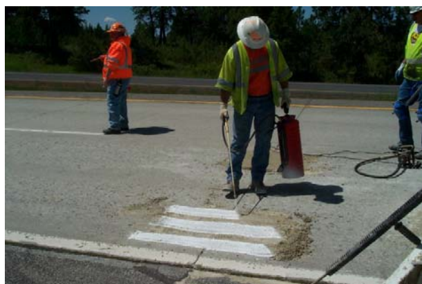
خ- عمل آوری محل شیارهای پر شده
