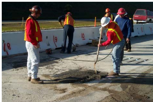
چ- پرکردن محل شیارها
