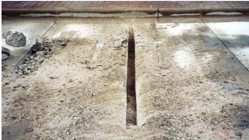
شکل ۴-۲۳- ایجاد برش آزادکننده در محلی که باید بتن برداشته شود
