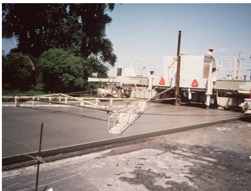
شکل ۳-۳۲- یک نوع ماله V شکل
