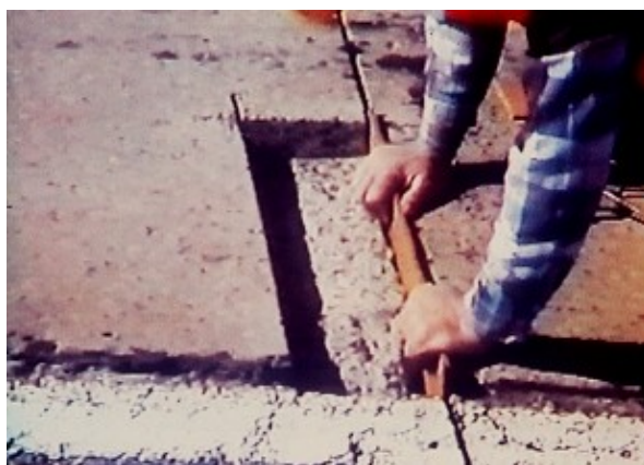
شکل ۴-۲۰- استفاده از میان‌درز هنگام مجاورت محل وصله با درز طولی یا عرضی
