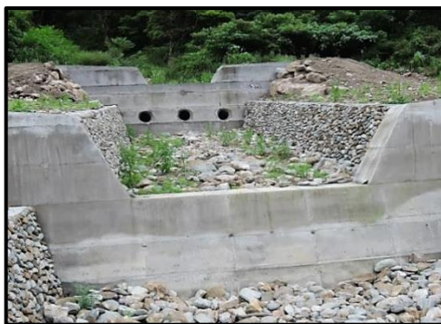
ب- سد رسوبگیر با ردیف کالورت‌ها (سازه بتنی)
