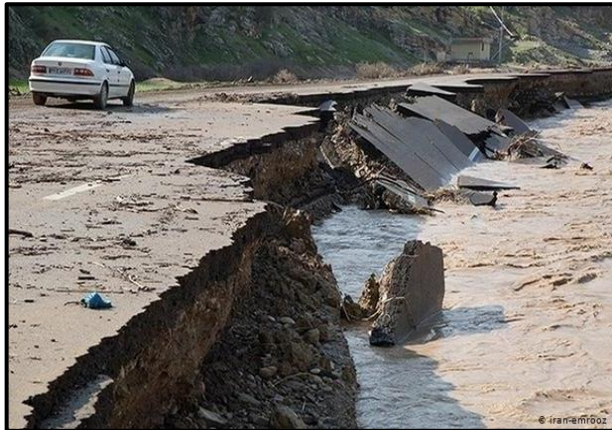
نمونه دیگر از توان فرسایشی و حمل مواد رسوبی و ناهنجاری‌های مورفولوژیک توسط سیلاب - سیلاب فروردین ماه ۹۸ - تبدیل مسیر جاده به رودخانه در دلفان لرستان
