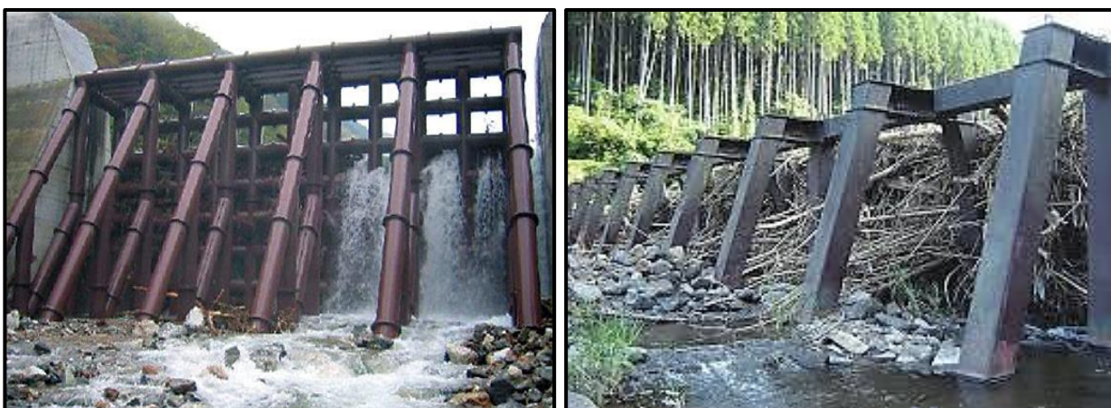
ب - نمونه‌هایی از سدهای رسوبگیر مشبک برای مهار رسوبات واریزه‌ای و قطعات سنگ و لاشه سنگ و الوار و اشجار در سطح حوضه آبریز
