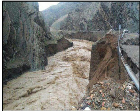
نمونه‌ای از قدرت تخریبی سیلاب در بازه‌های کوهستانی - فرسایش حاد کناره‌ها و انتقال مواد واریزه‌ای و مصالح درشت - سیلاب فروردین ماه ۹۸ - جاده سولقان
