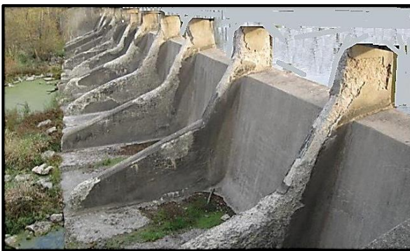
ب- سایش و خوردگی پوشش بتنی و تخریب لایه حفاظتی - منبع اینترنتی
