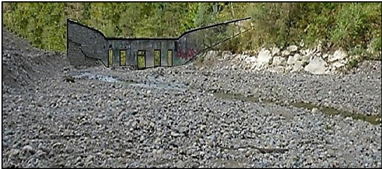
شکل ۲-۶- نمونه‌ای از انباشته شدن مواد رسوبی بار بستر در مخزن سد رسوبگیر باز، رودخانه رویز - فرانسه [۶۴]
