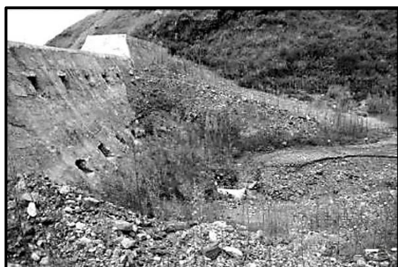
ب- مخزن سد رسوبگیر در مرحله تخلیه
