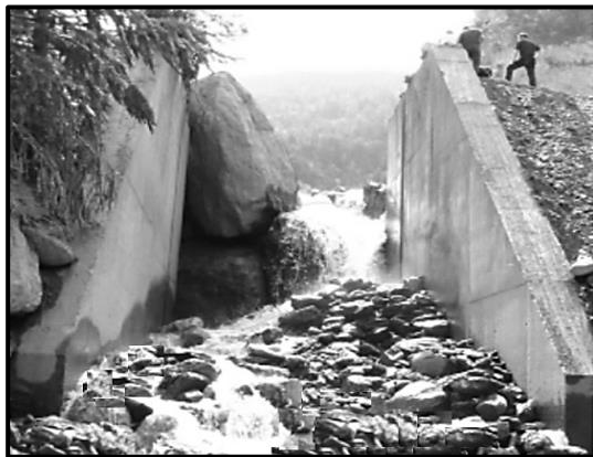
الف- سد رسوبگیر با شکاف منفرد برای تله‌اندازی بار بستر ب- سد رسوبگیر با شکاف منفرد با هدف مهار لاشه سنگ و صخره سنگ
