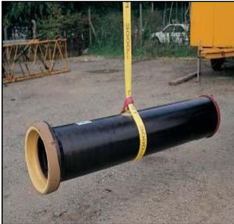
شکل ۲-۳۴- جابه‌جایی به روش یک تسمه‌ای
