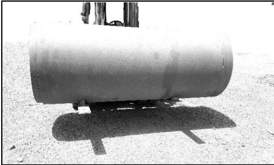
شکل ۲-۳- جابه‌جایی لوله با لیفتراک
