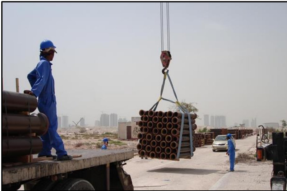
شکل ۲-۳۵- جابه‌جایی به روش دو تسمه‌ای
