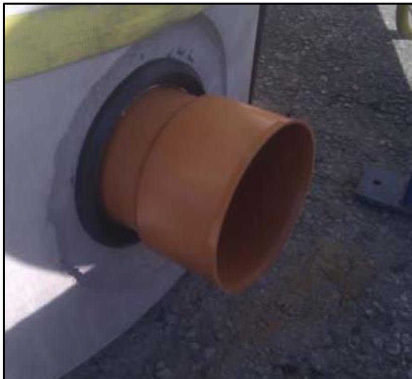
شکل ۴-۹- نمونه اتصال انعطاف پذیر لوله به آدمرو
