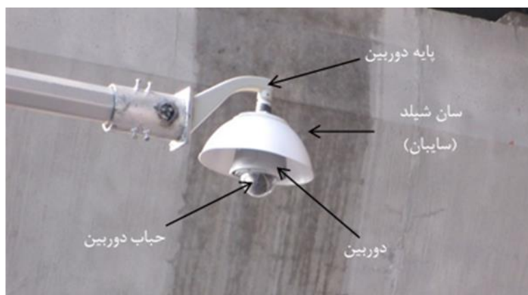
شکل ۹-۱: نمونه‌ای از دوربین نظارت تصویری و سایبان
