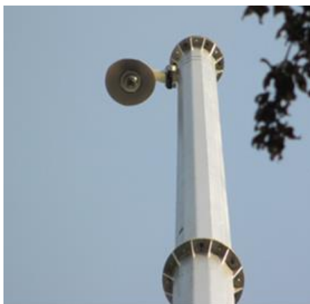
شکل ۹-۲: نحوه قرار گرفتن دوربین و سایبان روی یک نوع دکل
