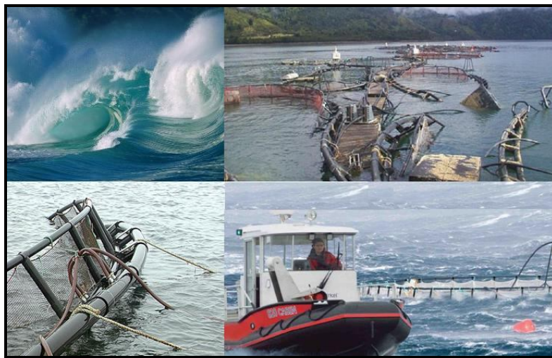
شکل ۱-۷- تخریب قفس‌ها در برابر باد و امواج
