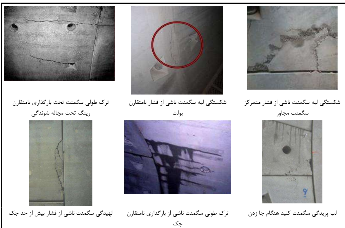
شکل ۶-۶- انواع آسیب سگمنت و علل آن
