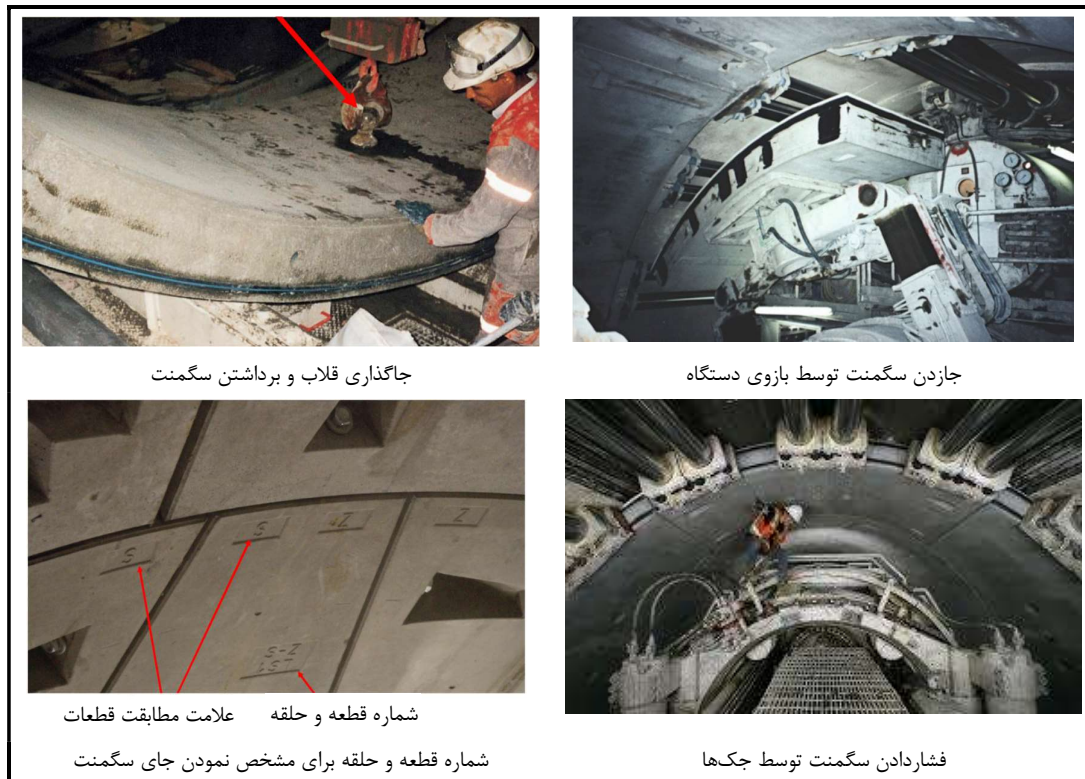
شکل ۶-۸- فرآیند نصب و جاذدن سگمنت
