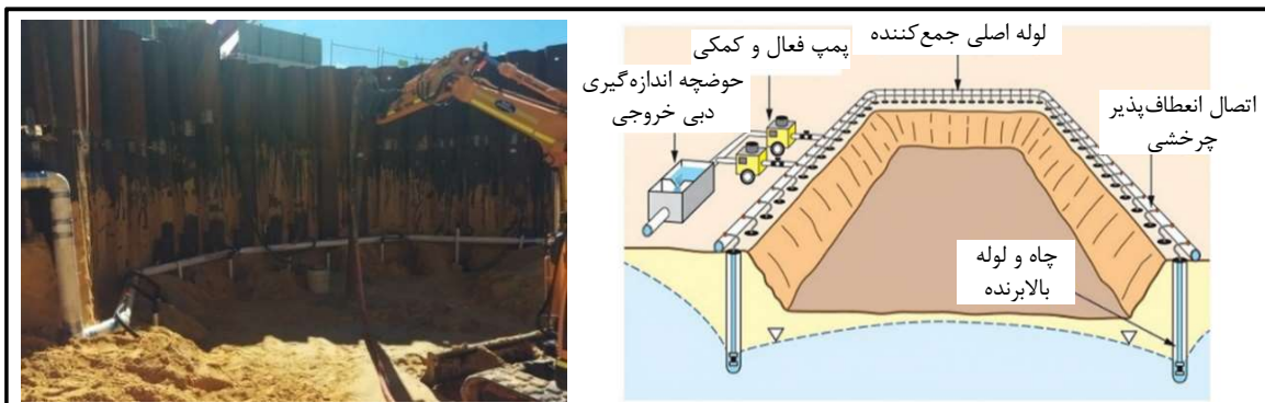
شکل ۵-۲- خشک‌اندازی ترانشه حفاری به روش چاه‌های زهکشی
