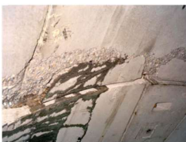
خردشدگی سگمنت در هنگام جا زدن
