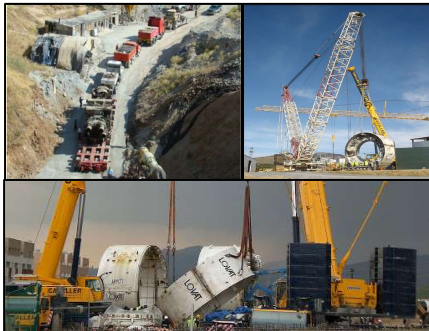
شکل ۵-۹- حمل و نقل قطعات دستگاه حفاری و مصالح به کارگاه تونل‌سازی در تونل‌های کرمان، بازی‌دراز و آزاد
