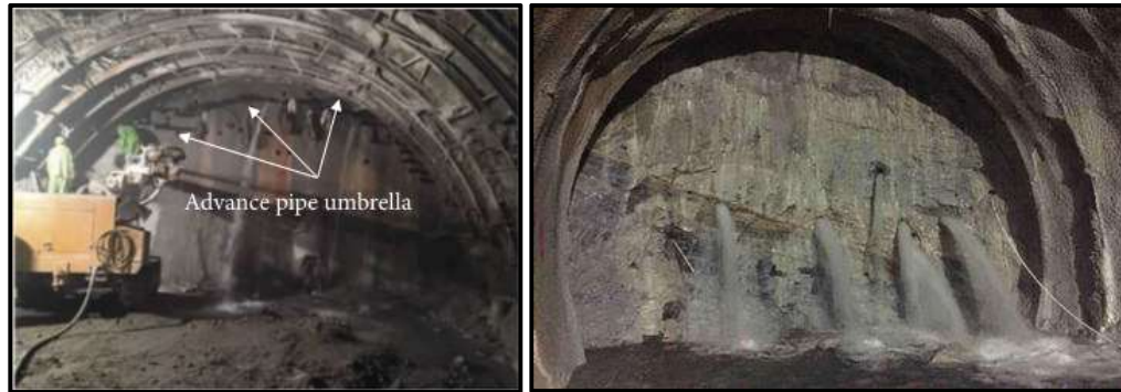
شکل ۳-۱۵- زهکشی پیش از حفاری برای کاهش هجوم و تراوش آب حین حفاری و نصب سیستم نگهداری
