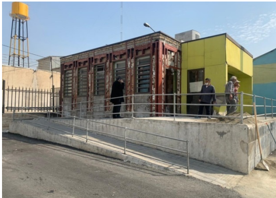
شکل پ-۱۵: سرویس‌های بهداشتی تیپ در منطقه ۱۰ شهرداری تهران با استفاده از سیستم LSF
