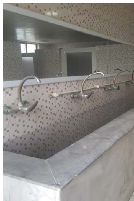
شکل پ-۹: عرض کم راهروهای داخلی در سرویس‌های عمومی بازدید شده - عدم امکان دسترسی به روشویی سرویس‌های بهداشتی برای افرادی که از صندلی چرخدار استفاده می‌کنند (شکل پ-۱۰).
