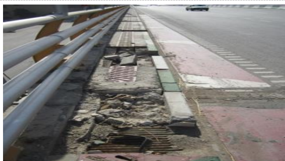
دریچه‌های زهکش‌ها مفقود شده‌اند
