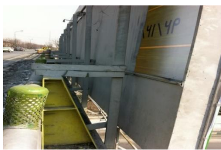
نصب تابلو (قطعات الحاقی غیر استاندارد) به نرده‌های پل
