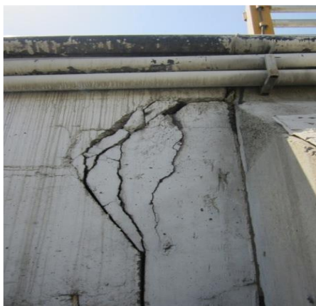
ترک عمیق با عرض زیاد در زیرسازه مشاهده می‌شود
