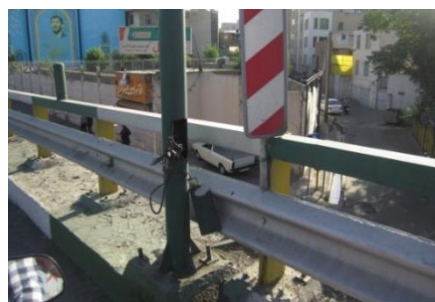
سیم‌های پایه روشنایی نمایان شده است
