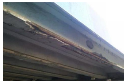
آثار برخورد وسیله نقلیه با زیر تیر، قلوه‌کن شدن، اضمحلال بتن و نمایان شدن آرماتورها در عرشه مشاهده می‌شود
