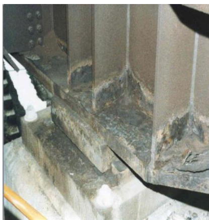
زنگ‌زدگی و خوردگی شدید بال پایین و سخت‌کننده‌ها مشاهده می‌شود
