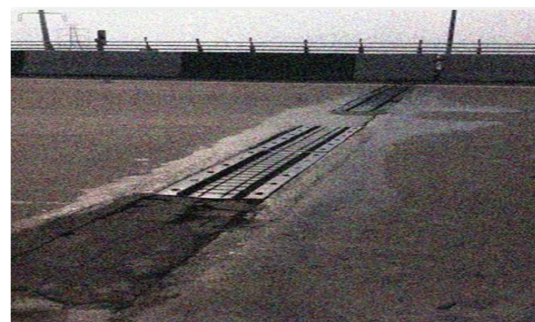
حرکات مشهود و سر و صدا هنگام عبور ترافیک در تمام خطوط عبوری، لاستیک از جا در آمده و با آسفالت جایگزین شده است
