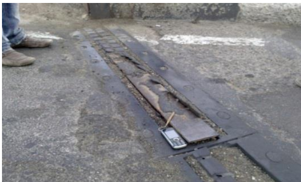
حرکات مشهود و سر و صدا در درز هنگام عبور ترافیک، از بین رفتن رویه لاستیکی صفحه و از جا بلند شدن صفحه روی درز
