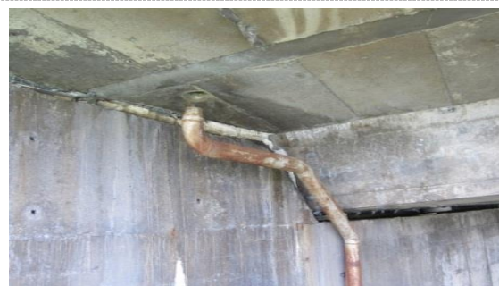
لگتجه از لوله جدا شده است و احتمال سقوط اجزاء وجود دارد
