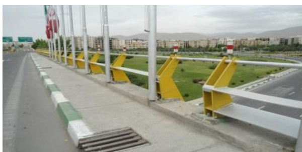
یک یا چند المان مربوط به نرده مفقود شده است و از ورق به صورت افقی برای المان‌ها استفاده شده است
