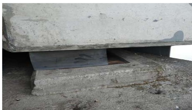
تکیه‌گاه الاستومریک از مکان خود جابه‌جا شده است.
