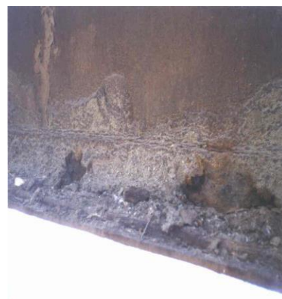
بال پایین تیر به شده زنگ زده و دچار خوردگی شده است.
