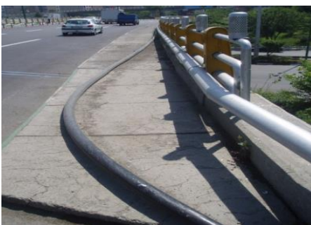
تأسیسات از سطح پیاده‌رو عبور داده شده‌اند
