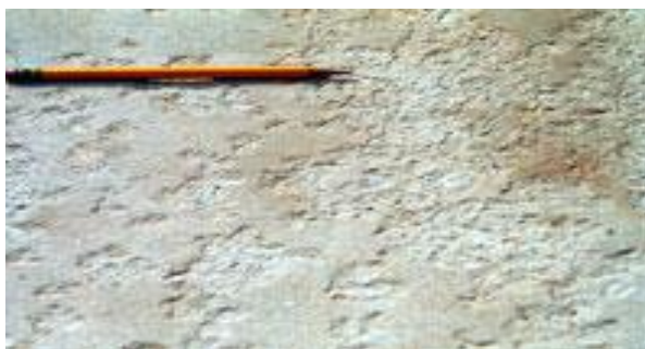
شکل ۱۷: پوسته شدن بتن
