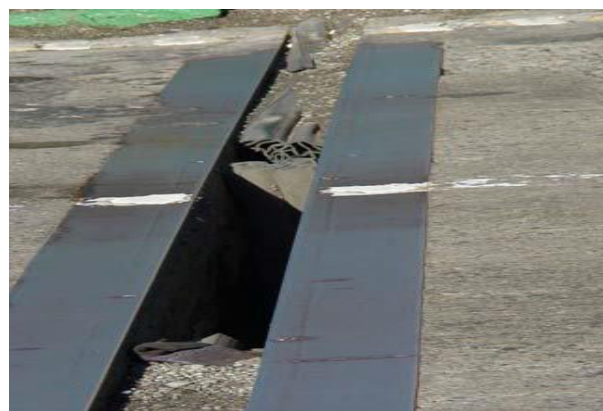
لاستیک درز کنده شده است و باعث اختلال در ترافیک عبوری شده است
