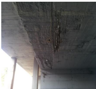
پوشش بتن از بین رفته است و آرماتورها نمایان شده‌اند
