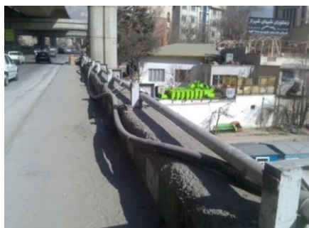
تأسیسات بطور نامناسب عبور داده شده‌اند
