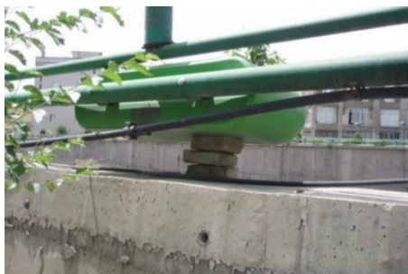
گلدان‌ها (قطعات الحاقی غیر استاندارد) به نرده‌ها متصل شده و زیر آن از چند قطعه آجر استفاده شده است
