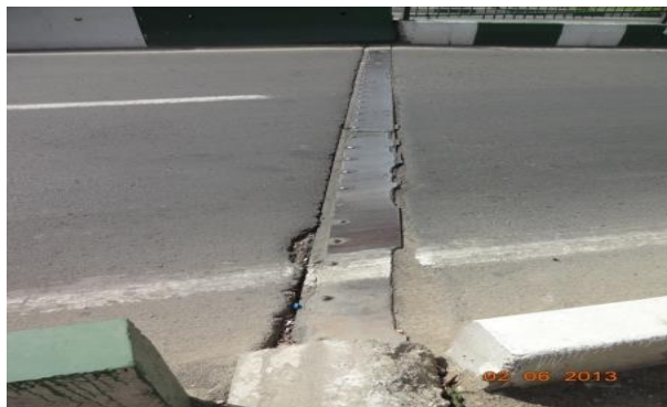
لق شدگی اجزاء درز و ایجاد سر و صدا هنگام عبور ترافیک، قلوه کن شدگی اطراف درز
