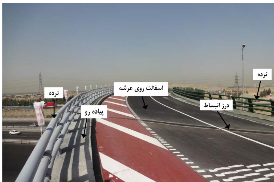
شکل ۱: نمایش اعضای متداول پل از روی عرشه
