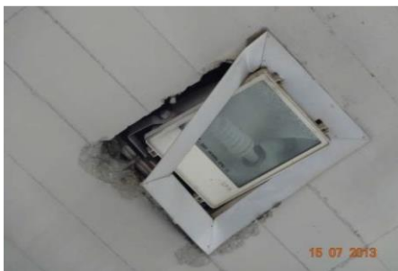
اتصالات نامناسب خطر سقوط و مشکلات ایمنی را به همراه خواهد داشت
