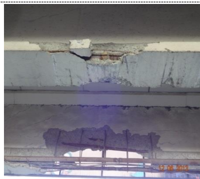
برخورد شدید با تیر رخ داده است و آرماتورها و کابل‌ها نمایان شده‌اند
