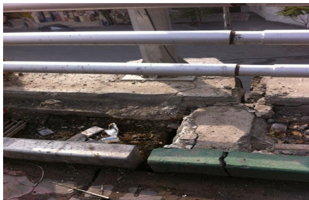
از بین رفتن پوشش سطح پیاده‌رو و ترک خوردگی عرضی جدول در امتداد درز انبساط
