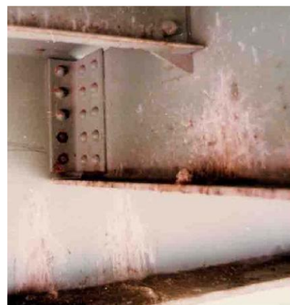
در محل اتصال آثار زنگ‌زدگی دیده می‌شود و تعدادی از پیچ‌ها مفقود شده است
