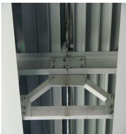
در محل اتصال تعدادی از پیچ‌ها مفقود شده و آثار زنگ‌زدگی دیده می‌شود.
