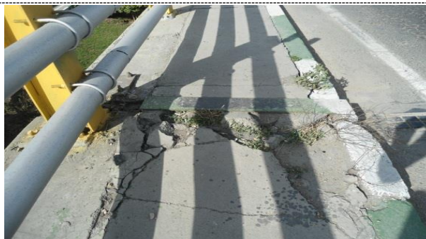
ترک در بتن قابل رویت می‌باشد و سطح پیاده‌رو نشست کرده است. جداول آسیب دیده‌اند. رنگ آمیزی از بین رفته و نیاز به رنگ مجدد دارد
