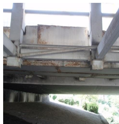
آثار زنگ‌زدگی در اجزاء فلزی وجود دارد.
