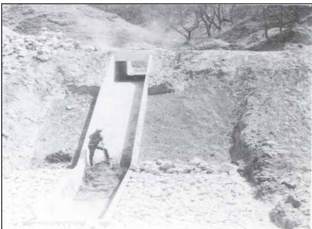
شکل ۲۱- ساختمان ورودی زهکش مایل با مقطع راست گوشه در کanal خاکی
