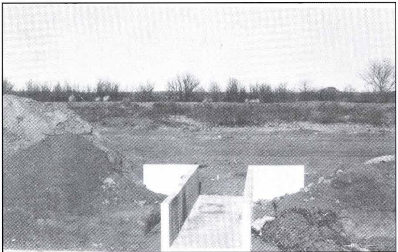
شکل ۲۲- ساختمان ورودی زهکش از نوع بتنی با مقطع راست گوشه در کanal با پوشش بتنی
