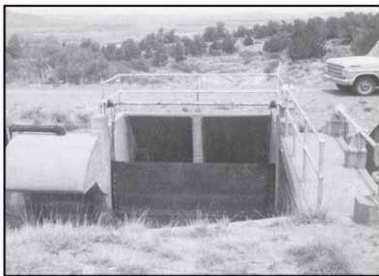
شکل ۷ - کلاهک سرریز سیفونی در چپ، دریچه قطاعی هرز آبرو در مرکز و بالا برند
