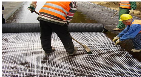
شکل ۴۶: نحوه رفع چین خوردگی ژئوگرید
