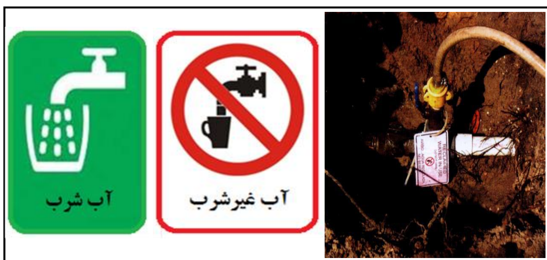
شکل ۲-۹ - تفکیک رنگ تجهیزات و استفاده از علائم در شبکه‌های دوگانه آب‌رسانی
