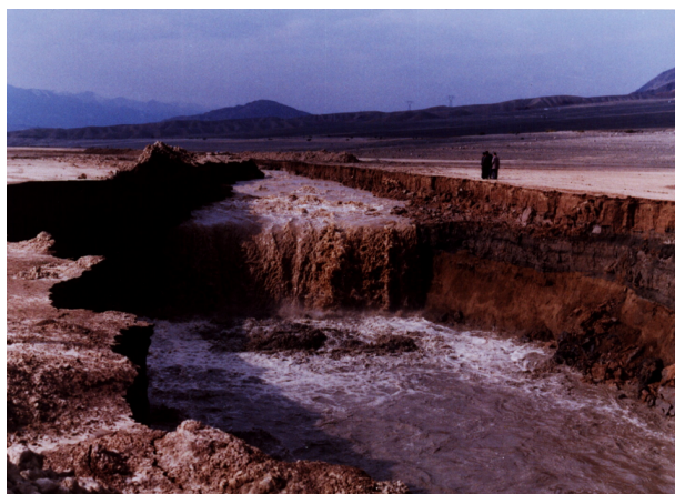
شکل ۴-۶- فرسایش پس‌رونده آبخاری در کانال فرسایشی در حین عملیات رسوبزدایی. منبع: کمیته‌ی رسوب سد سفیدرود
