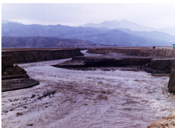
شکل ۴-۵- تعریض کانال تحت اثر فرسایش در حین عملیات رسوبزدایی. منبع: کمیته‌ی رسوب سد سفیدرود
