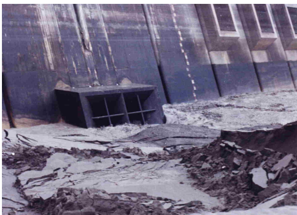
شکل ۴-۷- در هم کنش فرایندهای هیدرولیکی و مکانیک خاک در ضمن آزاد شدن تدریجی دریچه‌ها با انرژی آب. منبع: کمیته‌ی رسوب سد سفیدرود
