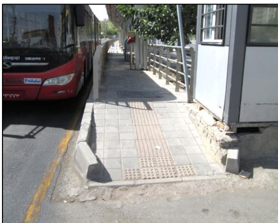
شکل ۴۴. اجرای خطوط بساوایی در داخل ایستگاه
