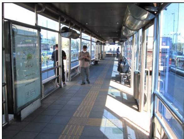
شکل ۴۴. اجرای خطوط بساوایی در داخل ایستگاه
